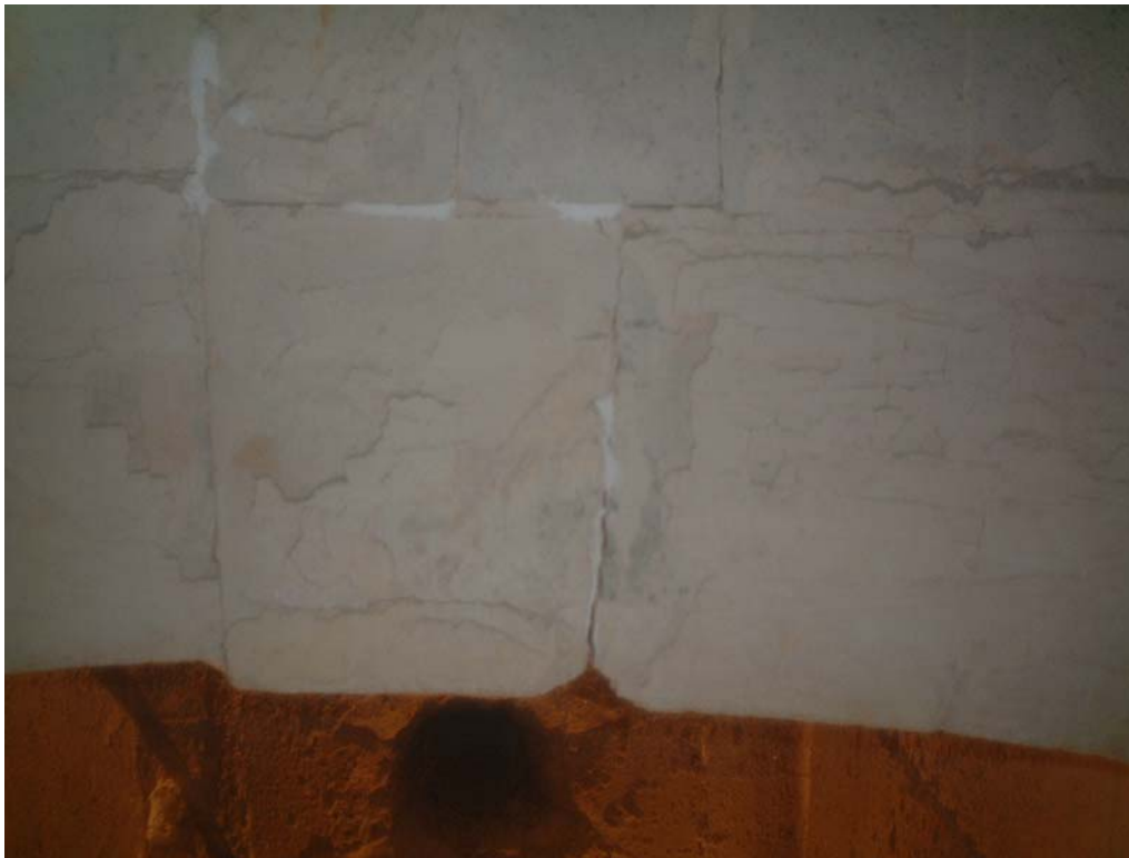
写真 2.1-1 アーチ部補修後
