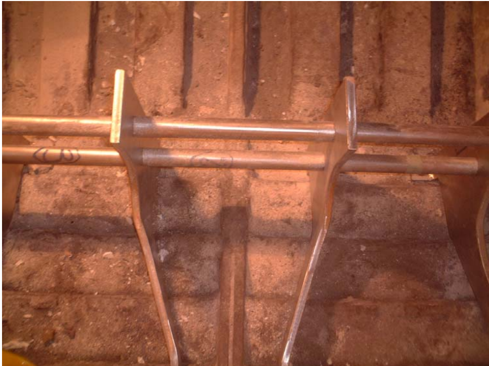
写真 2.1-6 新設カートンストッパー
