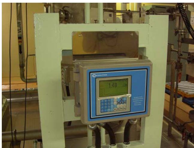
写真 2.2-3 新規流量計本体
