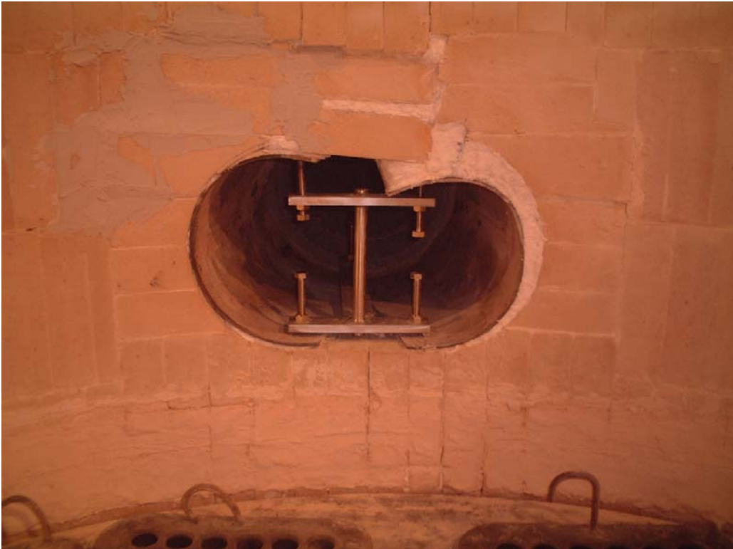
写真 2.1-10 ダクト変形防止治具
