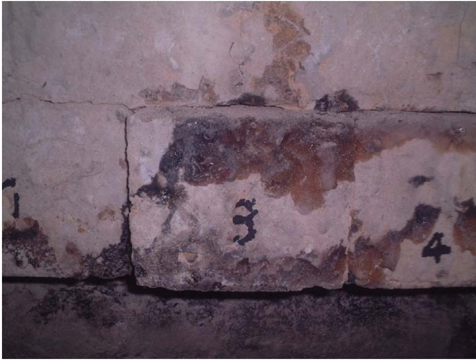
写真 2.1-7 火格子と干渉していた耐火レンガ
