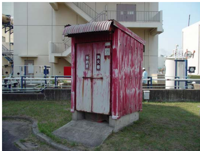
写真 2.2-14 既設消火器格納庫
