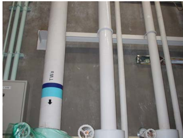
写真 2. 2-12 水噴霧消火設備配管（塗装後）
