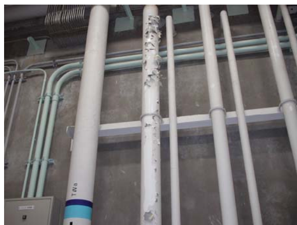
写真 2.2-10 水噴霧消火設備配管（塗装前）
