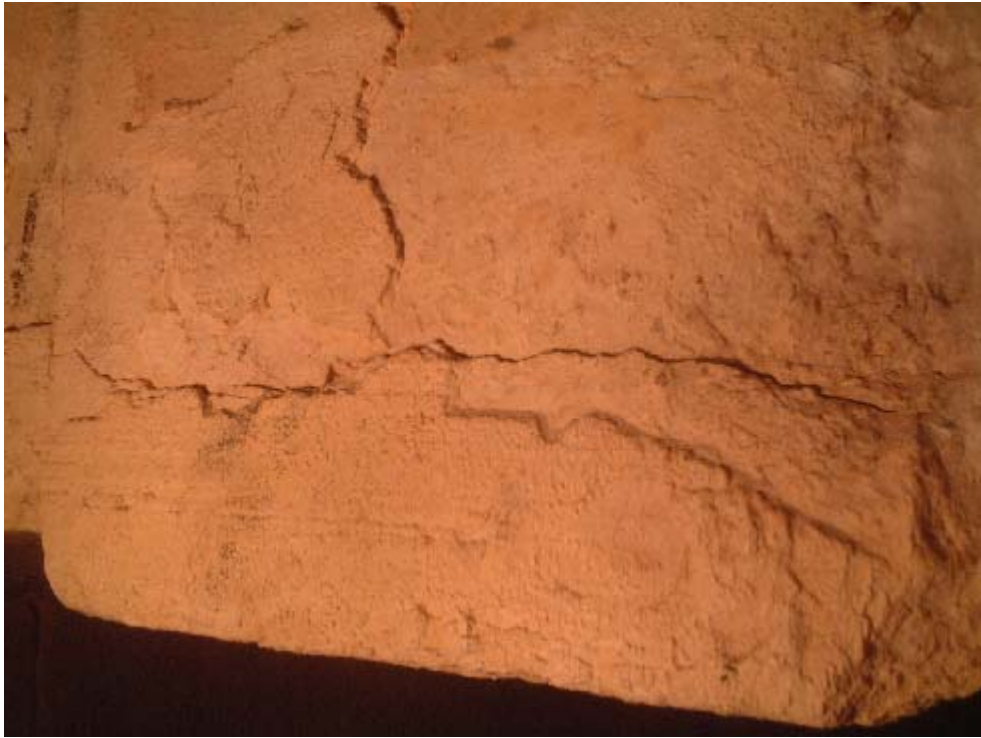
写真 2.1-3 廃棄物投入口アーチ部クラック
