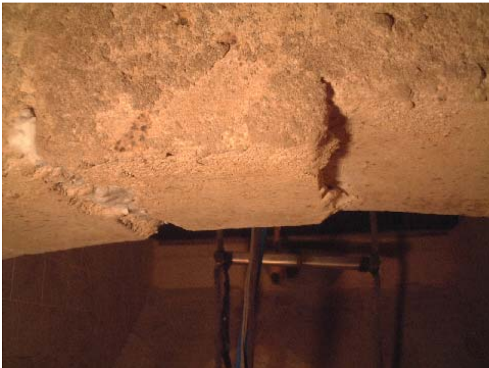
写真 2.1-4 二次燃焼室隔壁アーチ部せり出しレンガ
