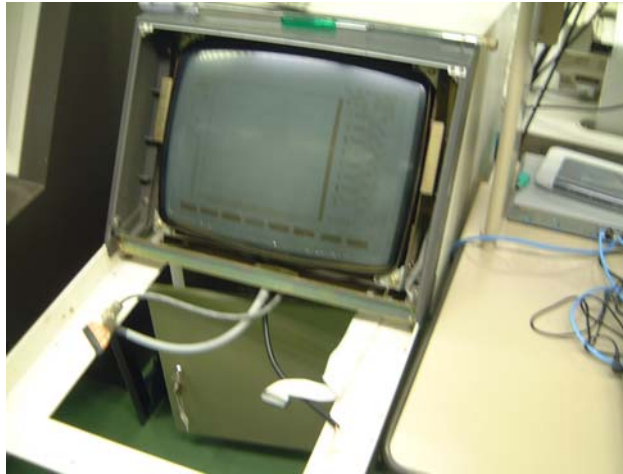
写真 2.2-7 監視装置(μEX)モニターの点検
