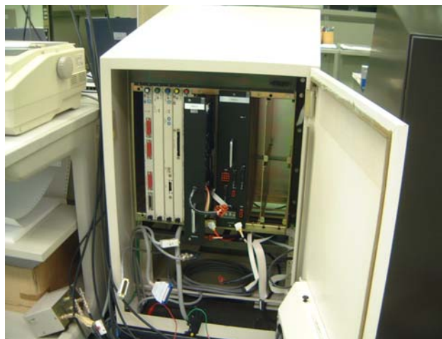
写真 2.2-6 監視装置( \mu EX)本体の健全性確認
