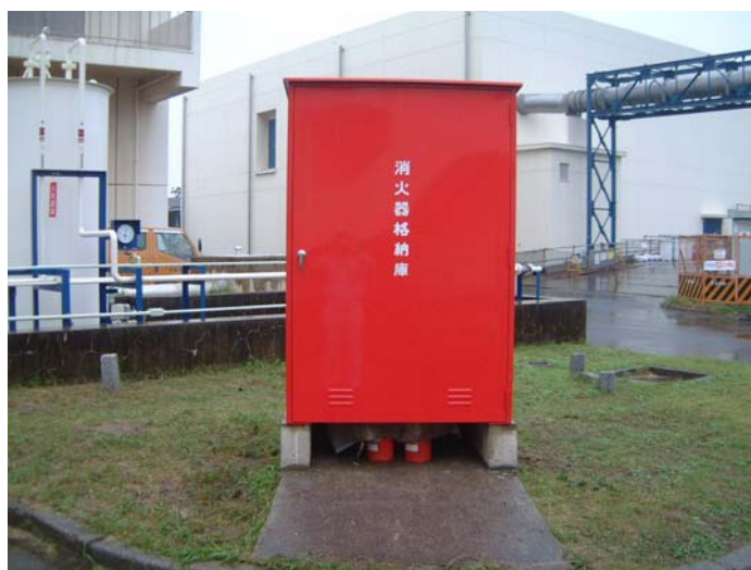
写真 2.2-15 新規消火器格納庫
