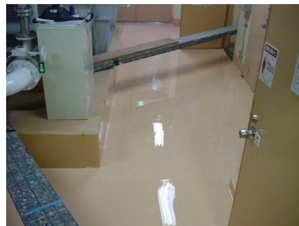
写真 2. 2-13 焼却炉室床面（エポキシ塗装後）
