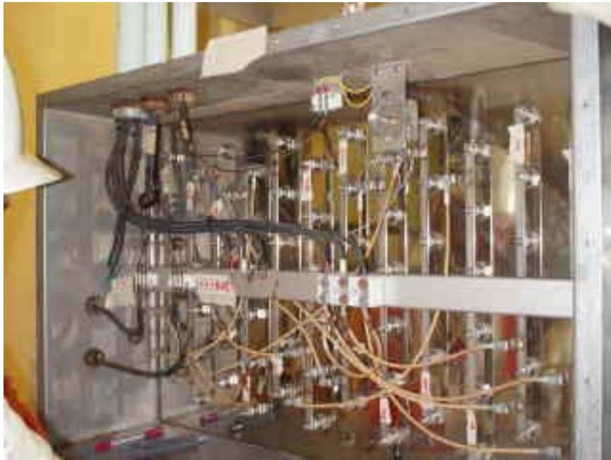
写真 2.2-4 H56 ヒータ端子箱内部 (配線更新前)
