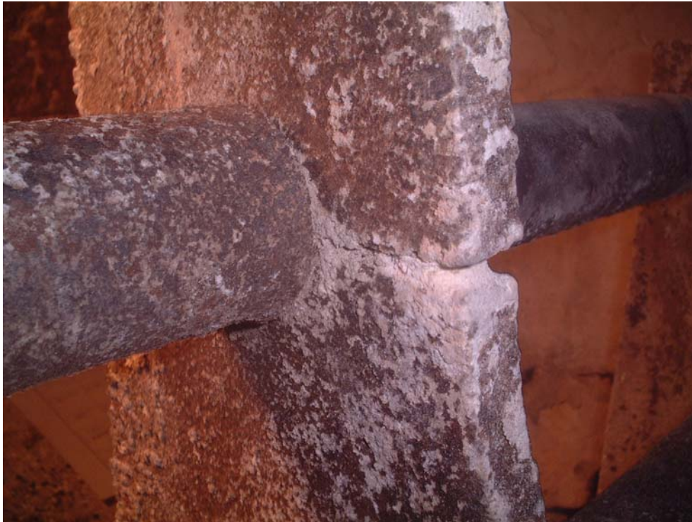
写真 2.1-5 カートンストッパー亀裂部
