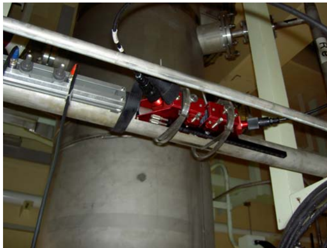
写真 2.2-2 新規流量計検出端 (トランスデューサー)
