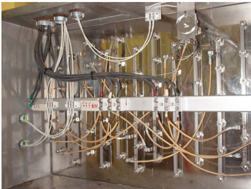
写真 2.2-5 H56 ヒータ端子箱内部 (配線更新後)
