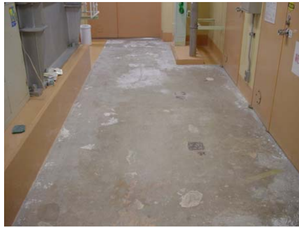
写真 2. 2-11 焼却炉室エポキシ床部全面剥離
