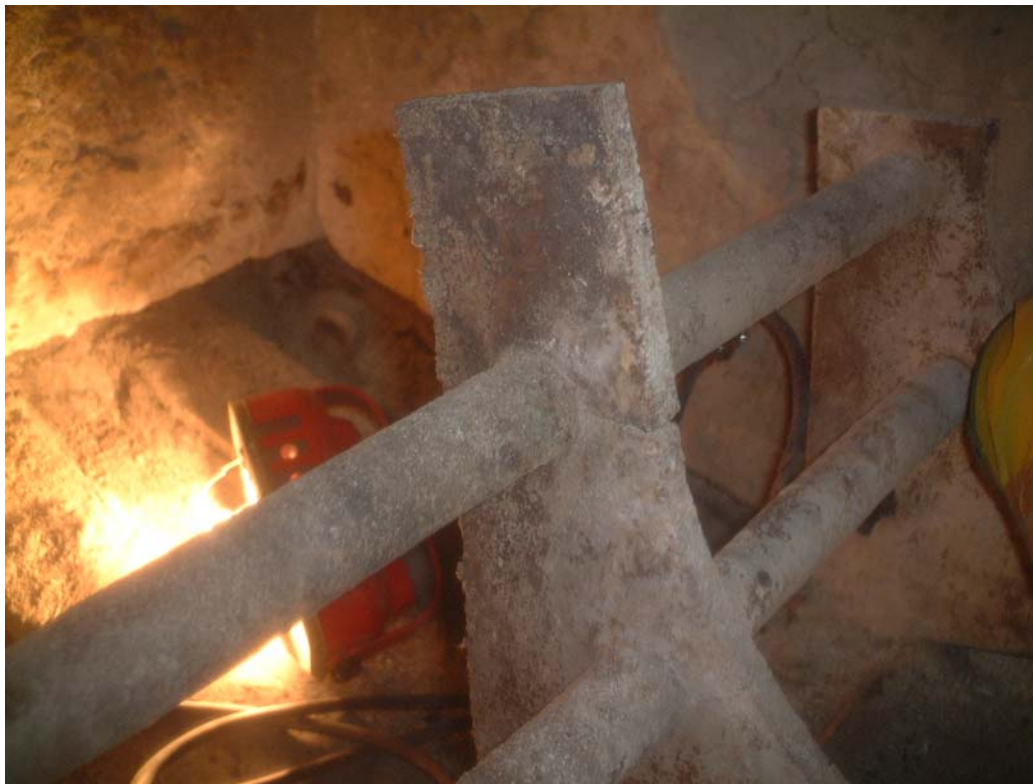
写真 2.1-2 カートンストッパー亀裂部
