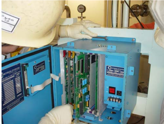
写真 2.2-1 既設流量計本体 (Wリレー接点出力基板の確認)
