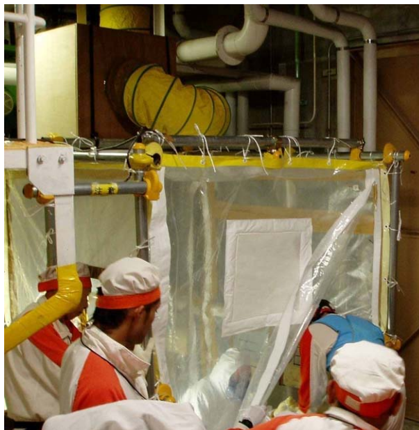
図 3.2 A021 バルジ内改造作業
