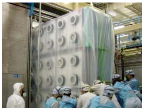
(解体設備への搬入風景)
