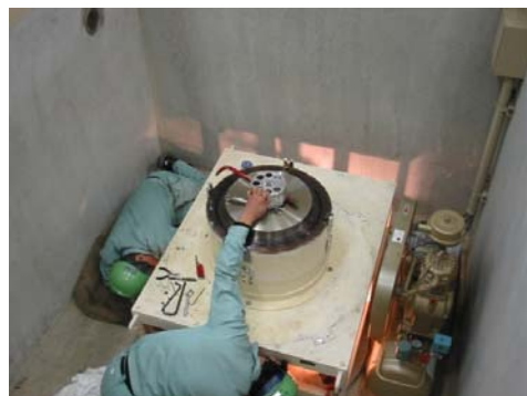
b) 線源選択ロータの取り外し
