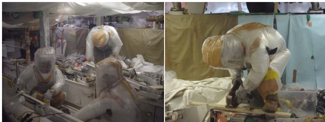
図 3.8 受払搬送設備の撤去・解体作業風景
