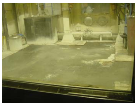
(解体設備内床面張替え風景)
