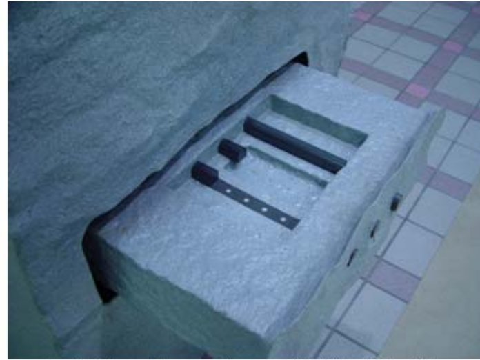
処分場200分の1スケール模型(左側)下部 - 処分坑道(処分孔豎置き方式のケース)を引き出す -
