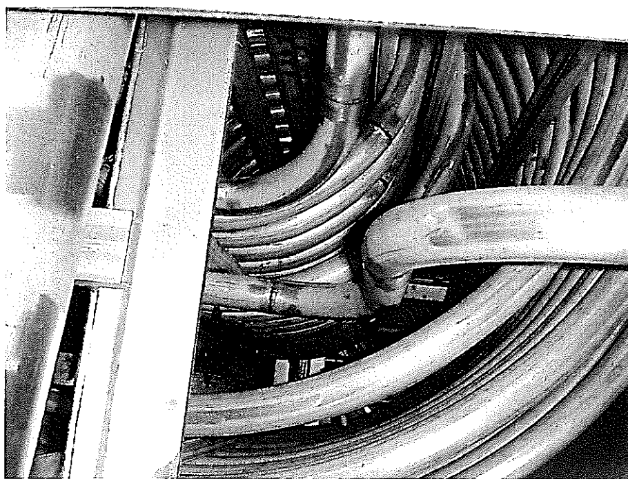
図3.6 新蒸気式窒素ガス気化器の外槽内部(蒸発管及び加圧管)の状況
