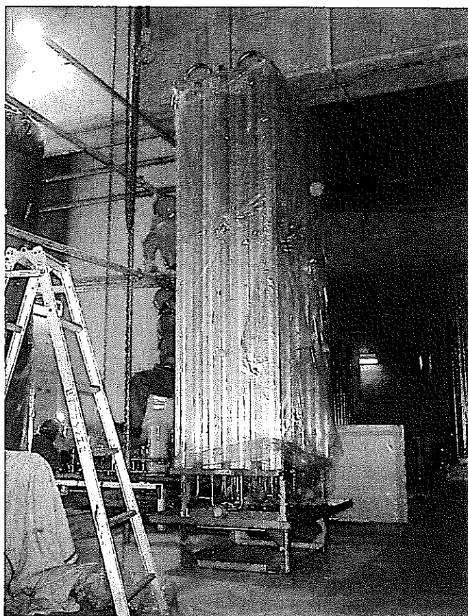
図3.7 空温式窒素送ガス気化器の据付状況
