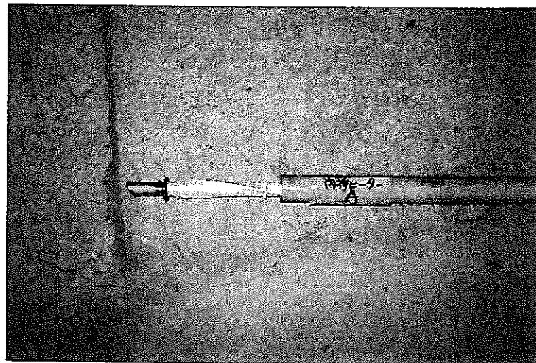
写真4-6-1 内挿ヒータ付2重配管の先端部組立図
