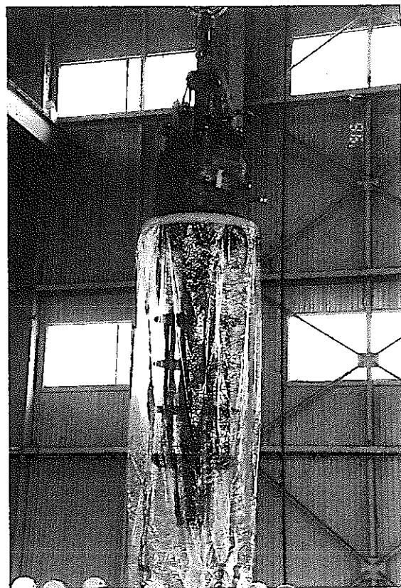
写真4-2-1 模擬過熱器内部構造物の吊り上げ
