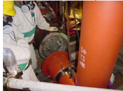
ダミー配管合わせ状況 (1次系出口配管)
