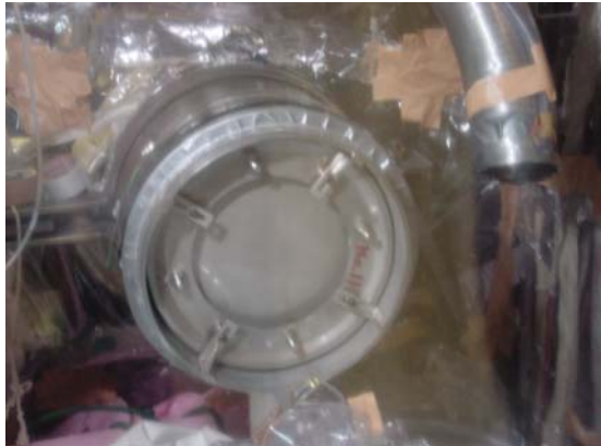
切断時の閉止キャップ+閉止治具（左）ヘキサプラグ（右）
