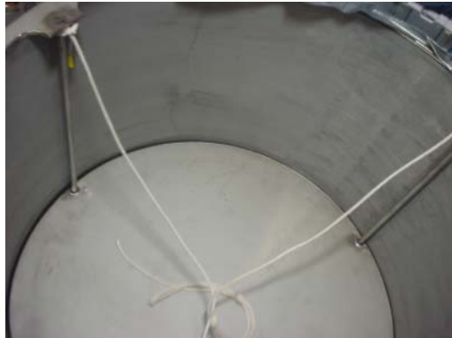
既設垂直配管治工具落下防止
