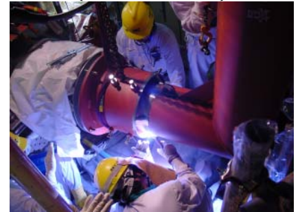
テンプレート溶接固定状況 (1次系出口配管)
