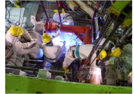
ダミー配管合わせ状況 (2次系入口配管)
