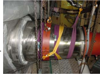
ダミー配管合わせ状況 (1次系入口配管)
