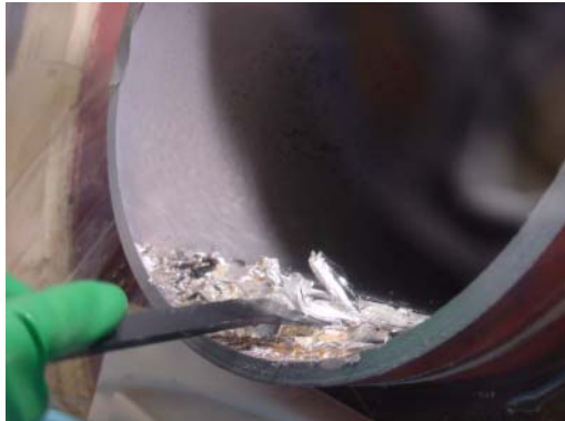
主IHX接続 2次系配管Na掻き出し
