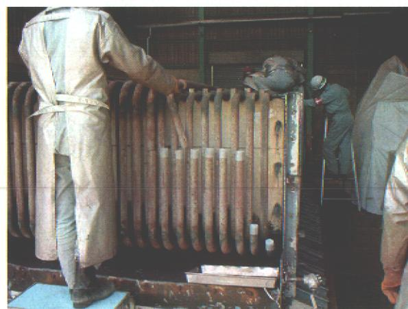
DHX 伝熱管のチップソーによる切断
