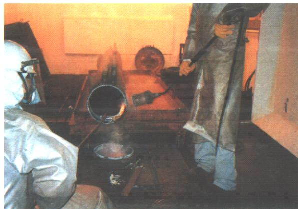
入口集合管の燃焼処理
