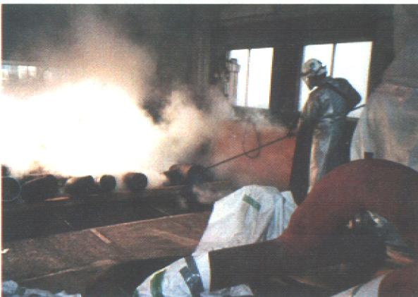
切断した配管の蒸気洗浄
