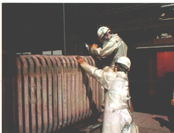
伝熱管のチップソーによる切断
