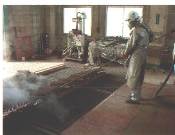
伝熱管の蒸気洗浄
