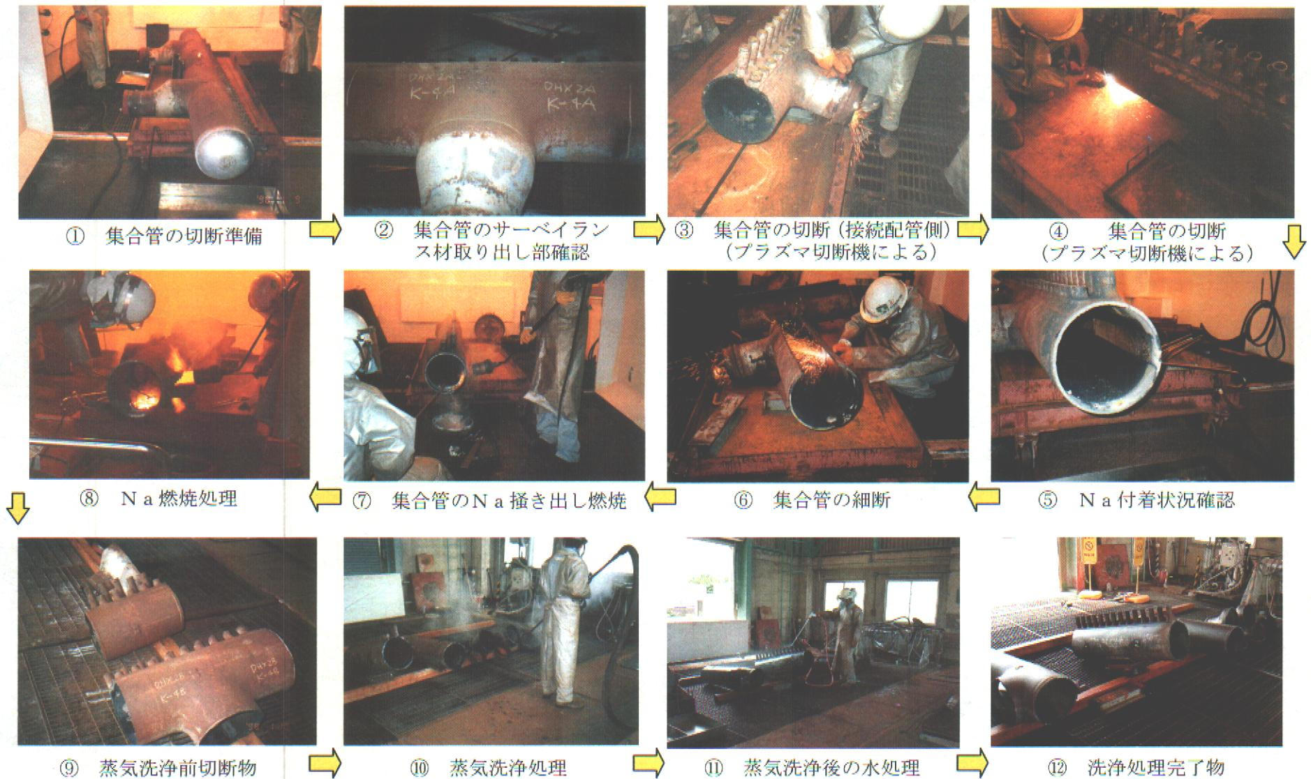
写真 5.1-1 主冷却器集合管の解体・ナトリウム洗浄の流れ
