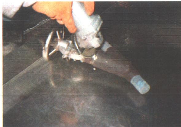
充填ドレン弁のリップ溶接部切断
