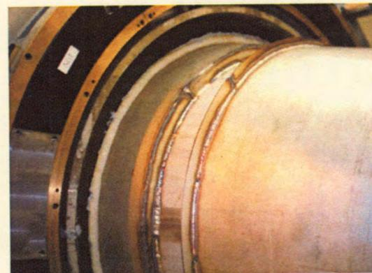
③外管閉止治具溶接
