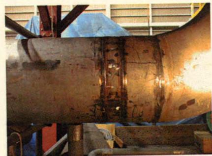
⑪外管溶接（1/2層溶接）
