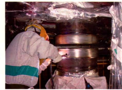
出口ノズル／出口撤去配管溶接状況
