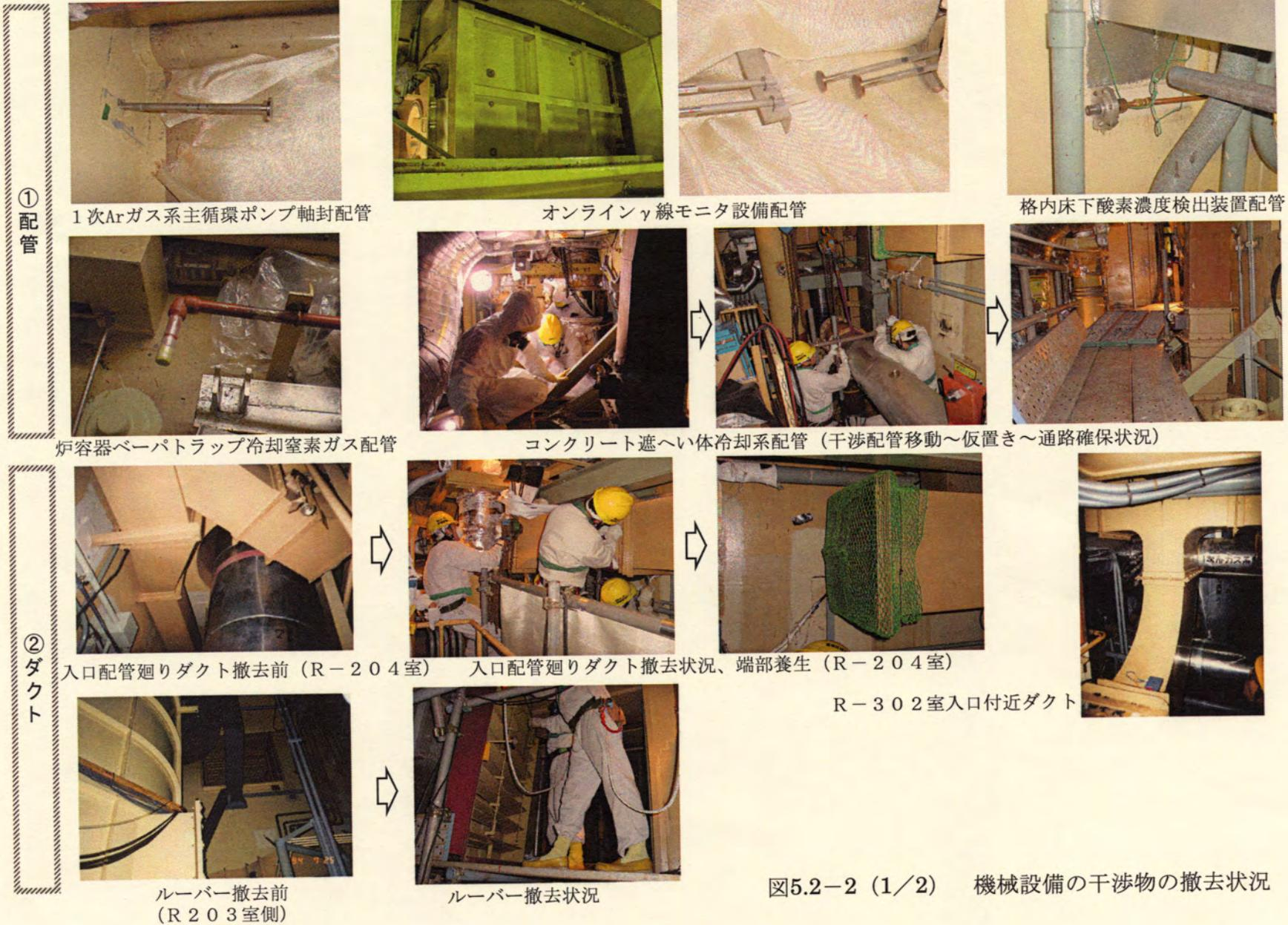
図5.2-2 (1/2) 機械設備の干渉物の撤去状況
