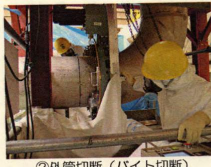
②外管切断（バイト切断）
