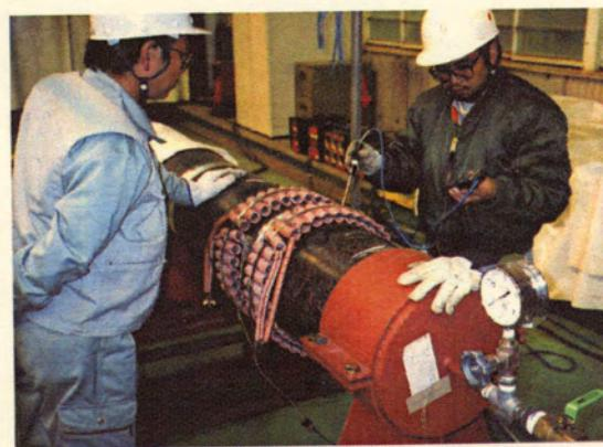
⑤配管温度測定 (STPA24配管溶接)
