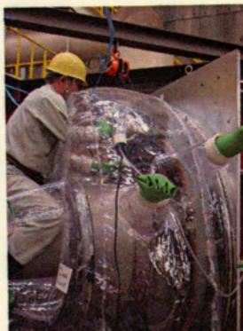
④内管切断（タガネによる切り残し部の切断状況）
