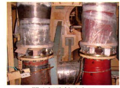
②予熱室素ガス系配管の保温改造
