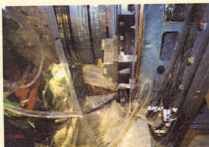
⑤内管追込み切削、シールバッグ取付け、アルゴンガス置換
