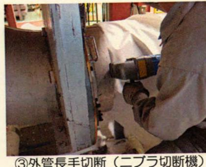
③外管長手切断（ニブラ切断機）
