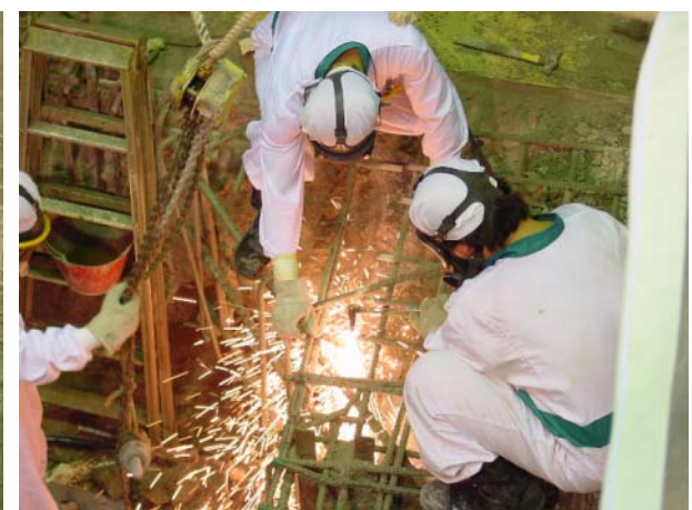
拡大開口部不要鉄筋の溶断
