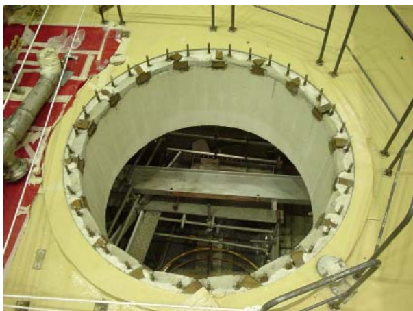
ポンプ洗浄槽引抜き後ベース部
