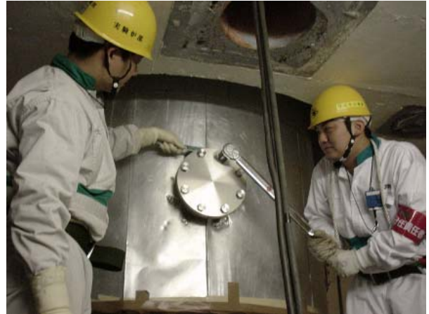
ポンプ洗浄槽配管接続フランジ部 (締付調整)
