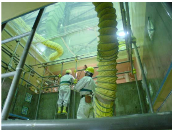
室内塗装作業
