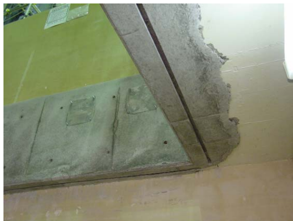
開口部後打ちコンクリート (形枠取外し)
