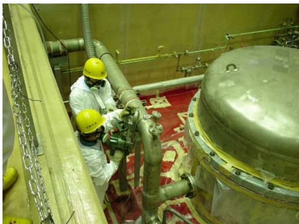
廃ガス配管の切断作業
