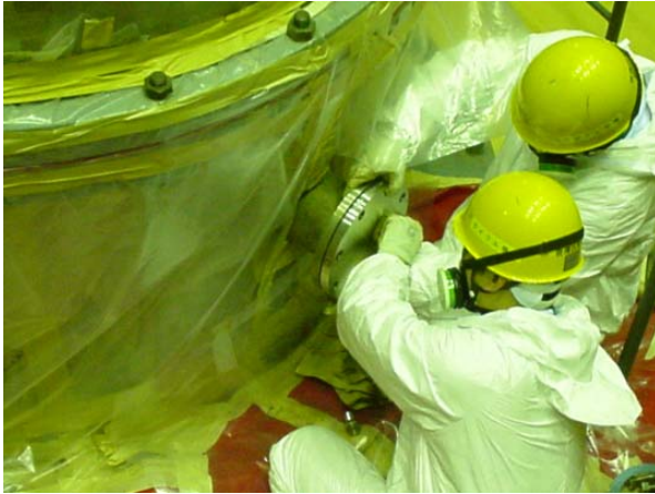
ポンプ洗浄槽配管接続フランジ部 (閉止板取付作業)
