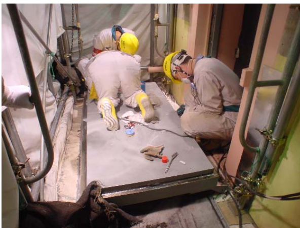
地下 2 階入口遮へい扉 (遮へい体強化鉄板の溶接作業)
