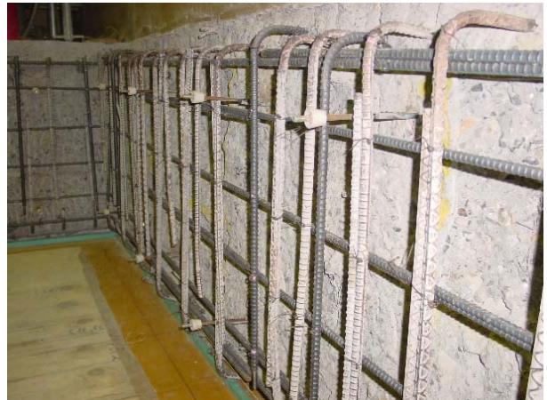
開口部鉄筋曲げ戻し後
