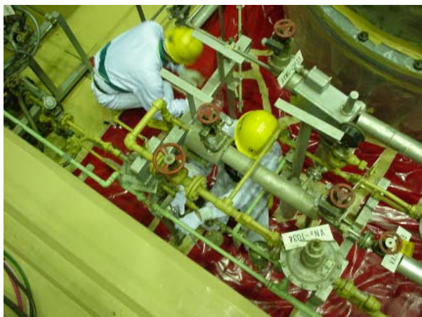
干渉配管の切断作業 (窒素ガス配管、圧縮空気配管)
