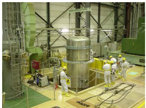
ポンプ洗浄槽の引抜き作業
