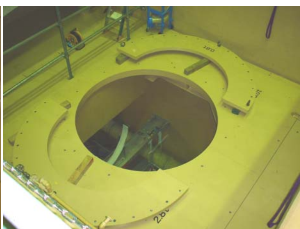
遮へい体 2 及び 3 設置
