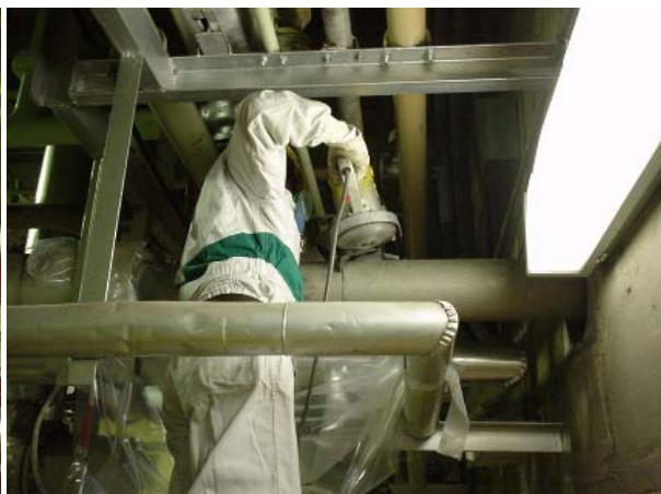
干渉配管のバンドソーによる切断作業 (6Bの蒸気配管)
