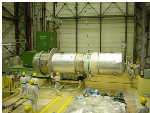
ポンプ洗浄槽引抜き作業 (横倒し終了)
