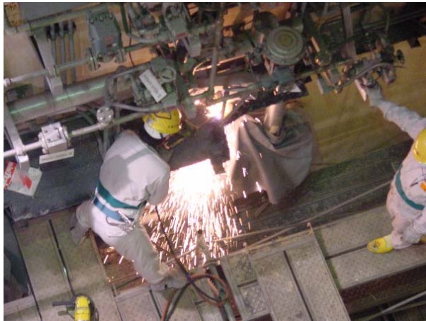
メンテナンス用架台撤去 (ガス溶断による撤去)
