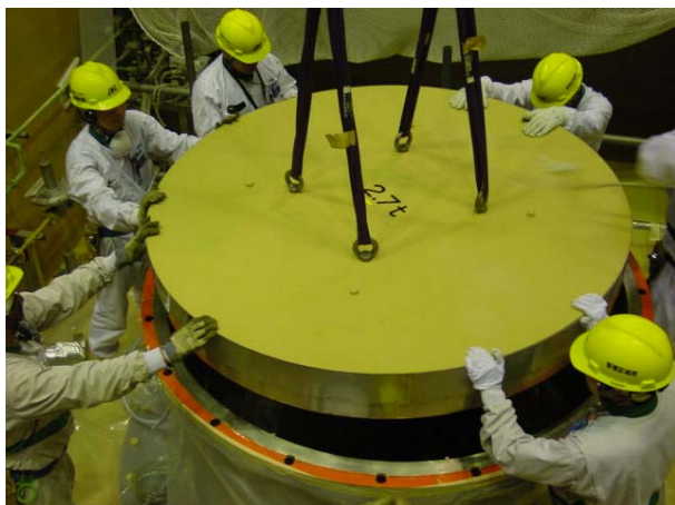
遮へい体 1 ポンプ洗浄槽内設置作業
