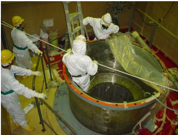
ポンプ洗浄槽内洗浄カゴの固定作業
