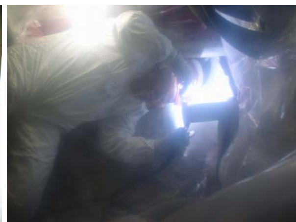
廃液配管の閉止フランジ溶接作業 (グリーンハウス内作業)
