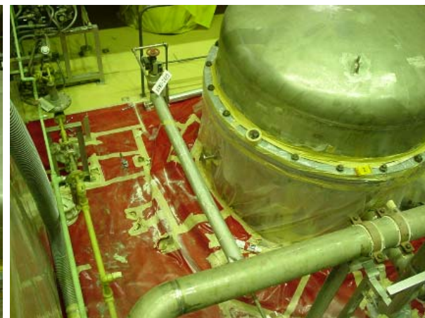
干渉配管の撤去後 (GL-2,000mm) (窒素ガス配管、圧縮空気配管)
