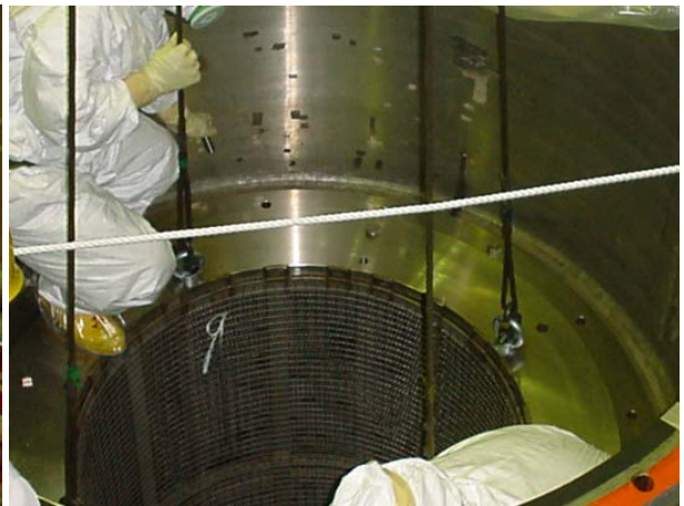
ポンプ洗浄槽内洗浄カゴの固定作業
