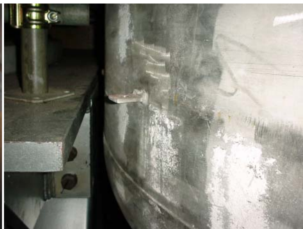
ポンプ洗浄槽と旧主中間熱交換器(B) 保管架台との据付ギャップ (約 33mm)
