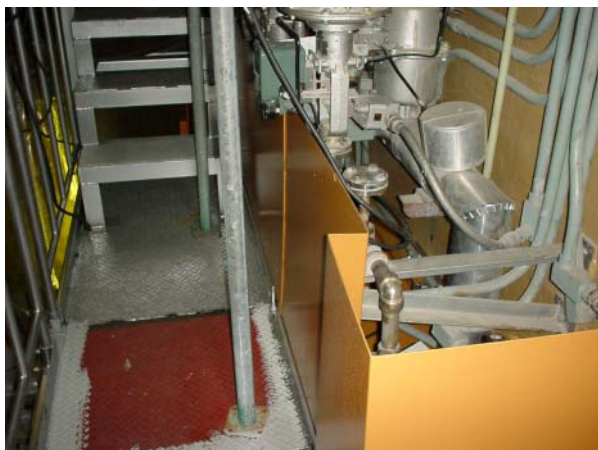
固体廃棄物貯蔵設備室内の洗浄水配 管及び廃液配管への受樋設置
