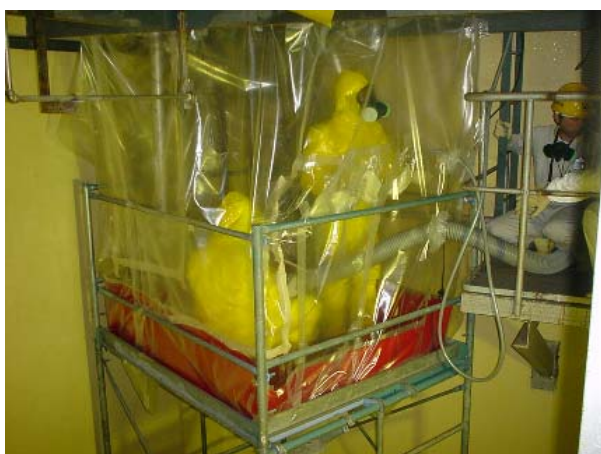
廃液配管の切断作業 (グリーンハウス内作業)
