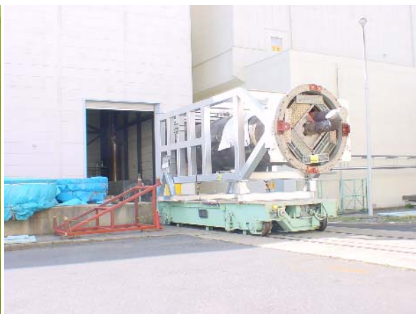
旧主中間熱交換器の原子炉建物から メンテナンス建物への移動
