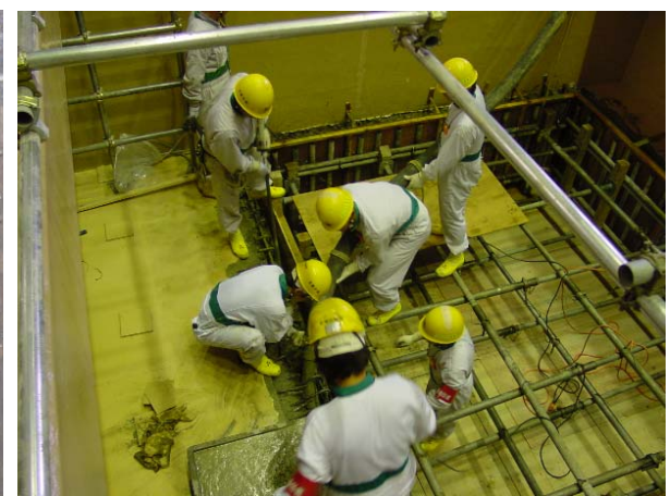
開口部コンクリート流し込み作業
