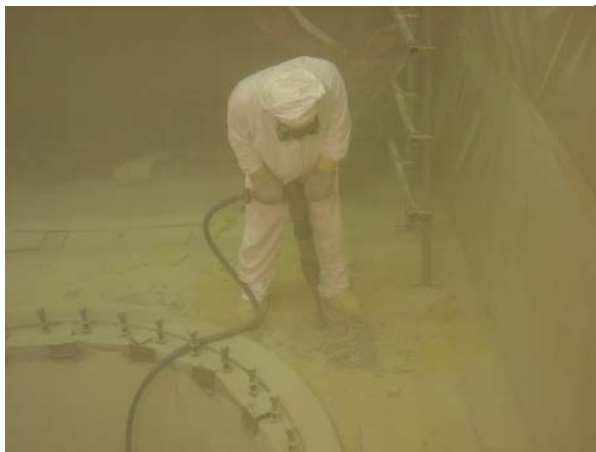
ハンドブローカーによる表層はつり作業
