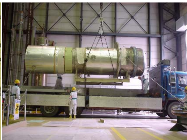
ポンプ洗浄槽メンテナンス建物から第 一使用済燃料貯蔵建物への移動
