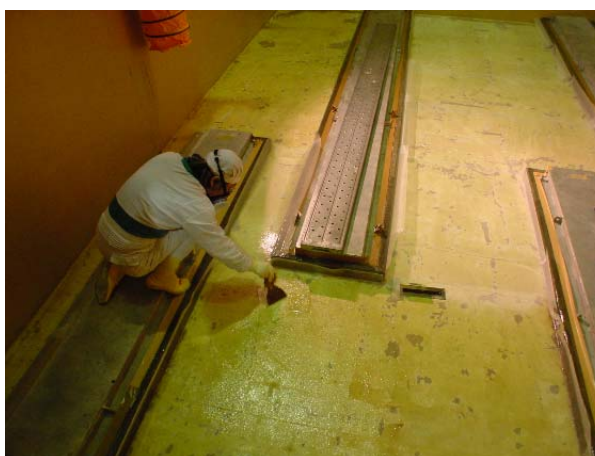
旧主中間熱交換器保管架台 固定金具設定及び壁面塗装状態
