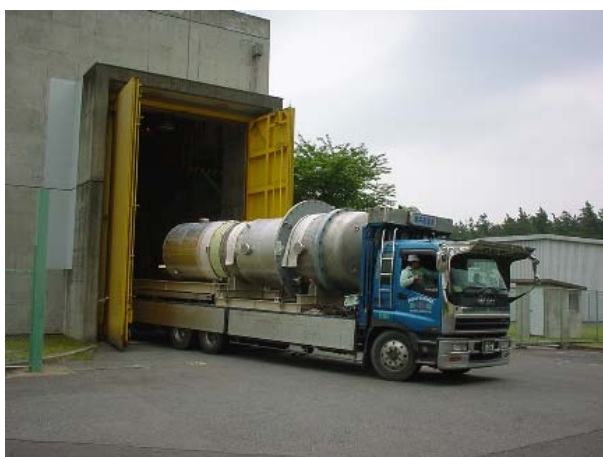
ポンプ洗浄槽第一使用済燃料貯蔵建物 への搬入
