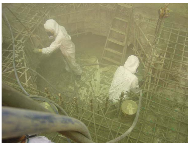
ハンドブローカーによるはつり作業
