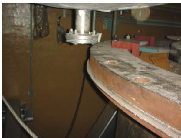
ポンプ洗浄槽と旧主中間熱交換器(A) フランジとの据付ギャップ (約 68mm)
