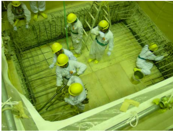
開口部鉄筋曲げ戻し作業
