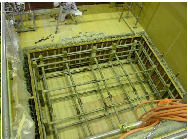
開口部コンクリート流し込み形枠設定
