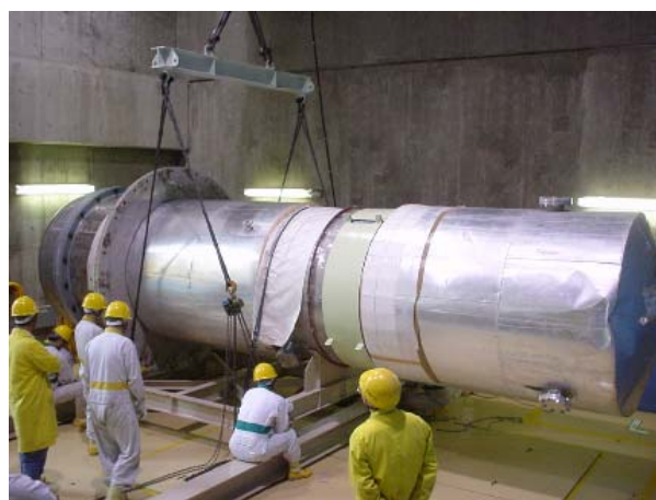
ポンプ洗浄槽第一使用済燃料貯蔵建物 での一時仮置き
