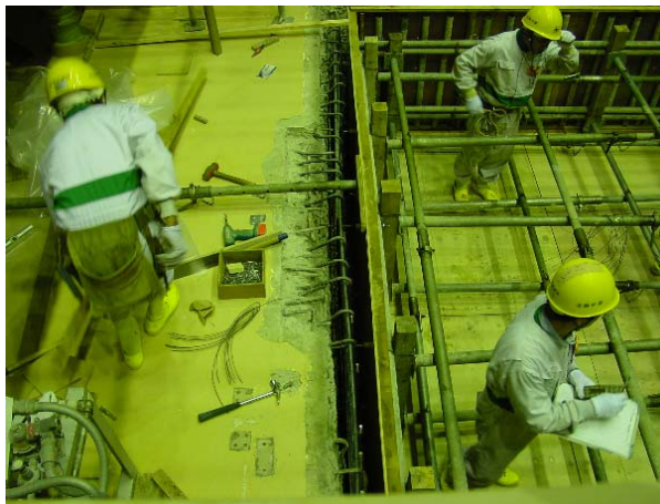
開口部コンクリート流し込み形枠設定
