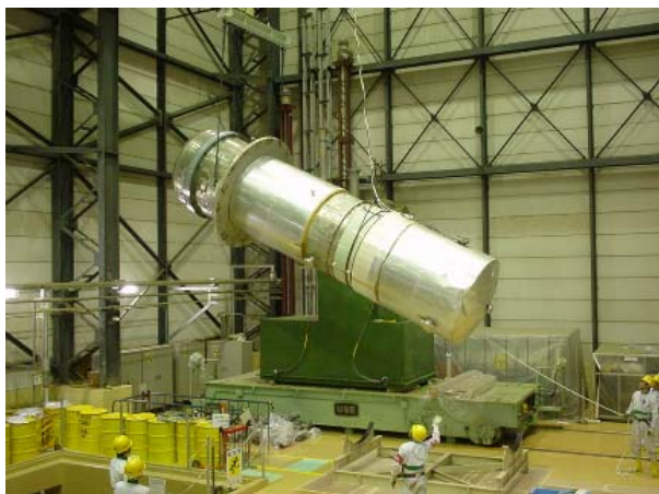
ポンプ洗浄槽の引抜き作業 (天井クレーンの主巻と補巻を使用し た横倒し)
