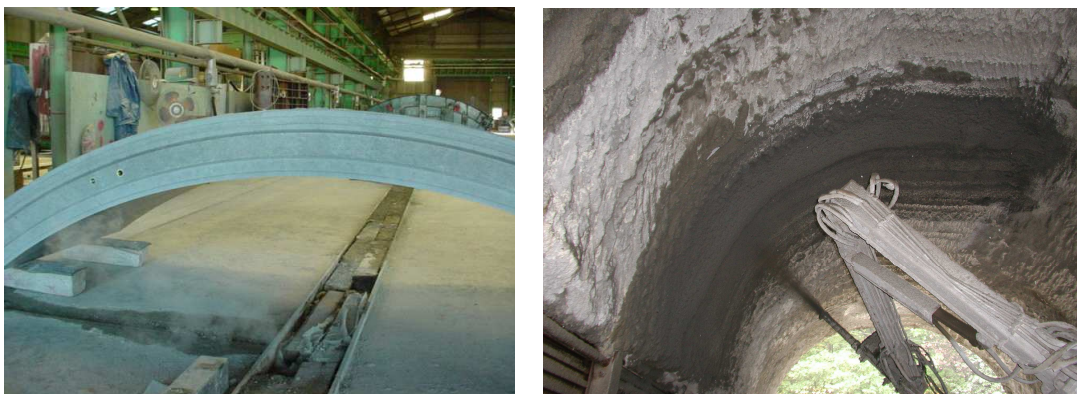
図-2 セグメント及び吹き付けコンクリートの施工状況 (左図：セグメント，右図：吹き付けコンクリート)
