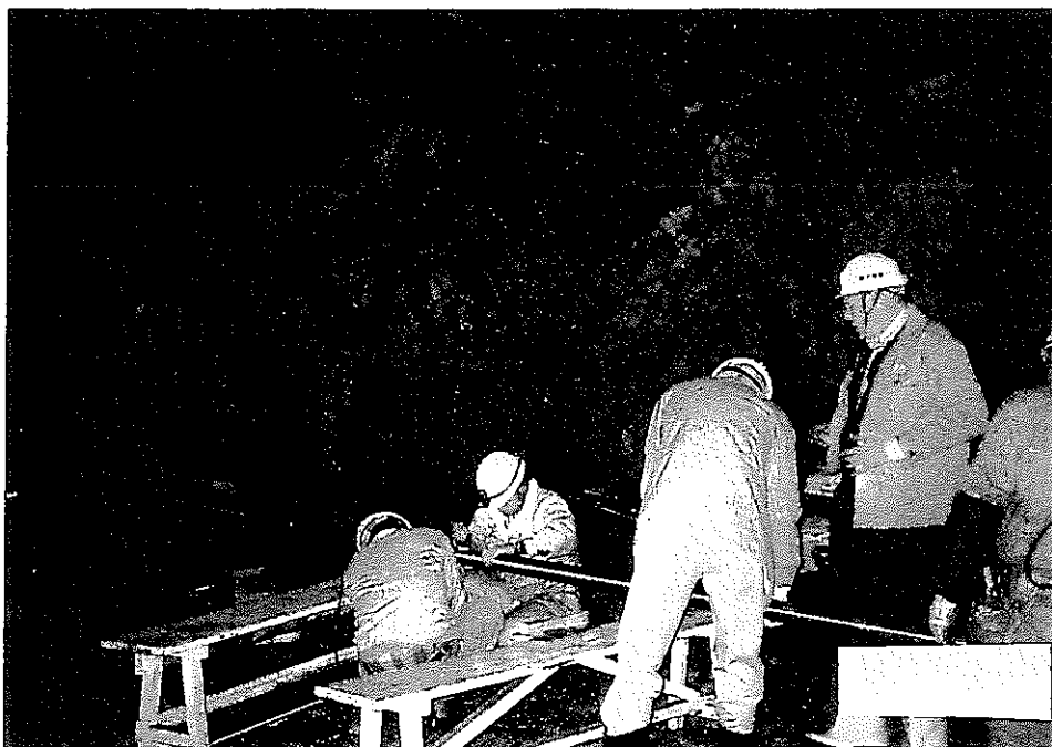
写真-8.4.7 パッカー設置状況（その3）
