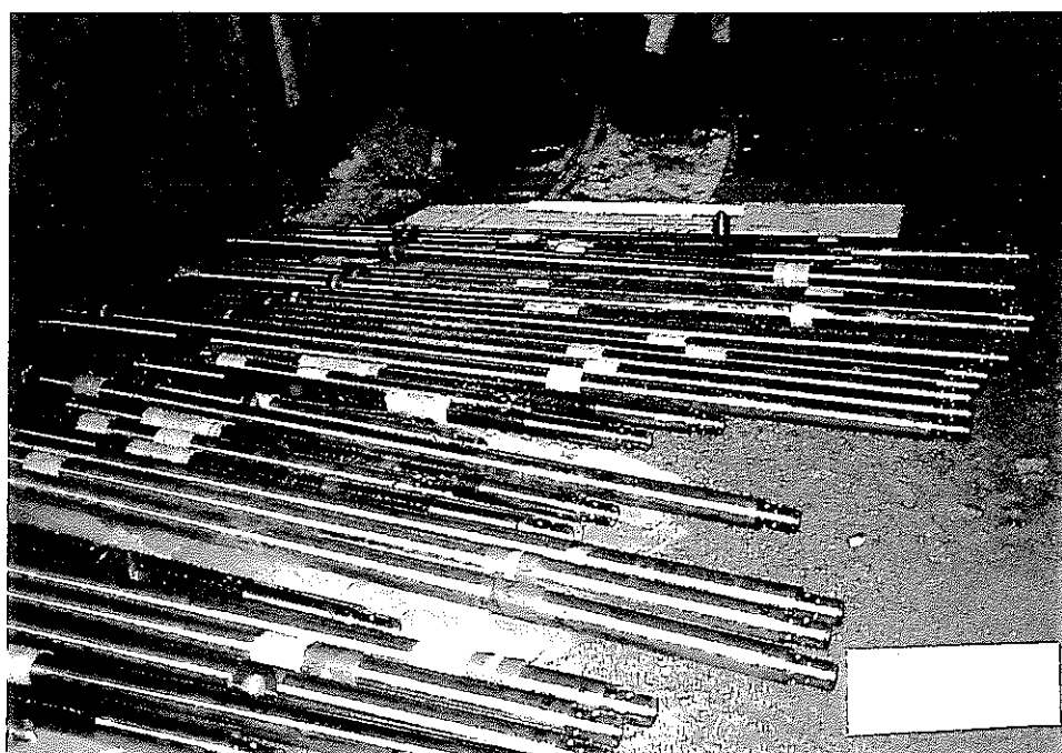
写真-8.4.5 パッカー設置状況（その1）
