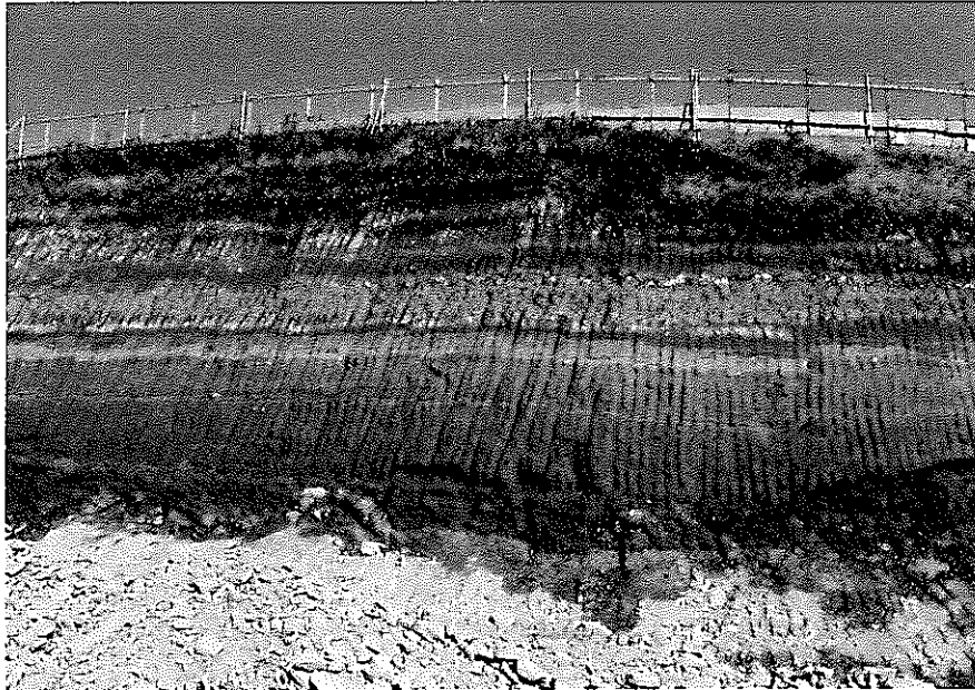
写真 2 5 三崎面を構成する三崎砂礫層と武蔵野ローム層
