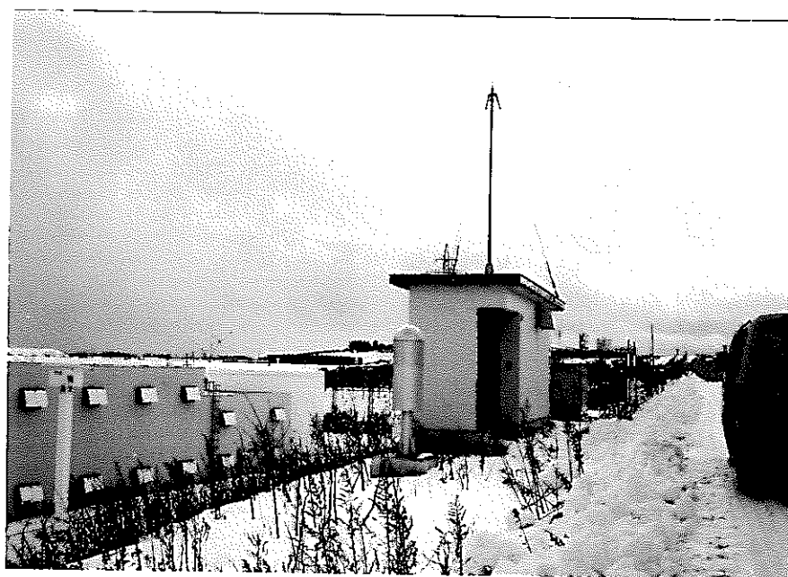
写真3.1－6 空間放射線量率監視用モニタリングステーション
