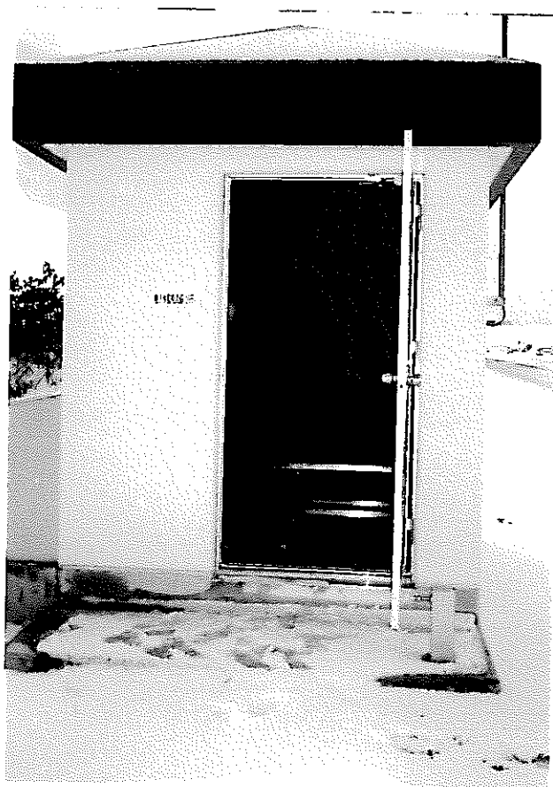
写真3.1－4 地下水監視設備
