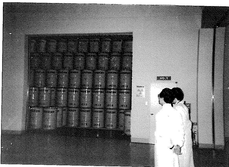
写真3.2-1 200ℓドラム缶による廃棄物の貯蔵状態
