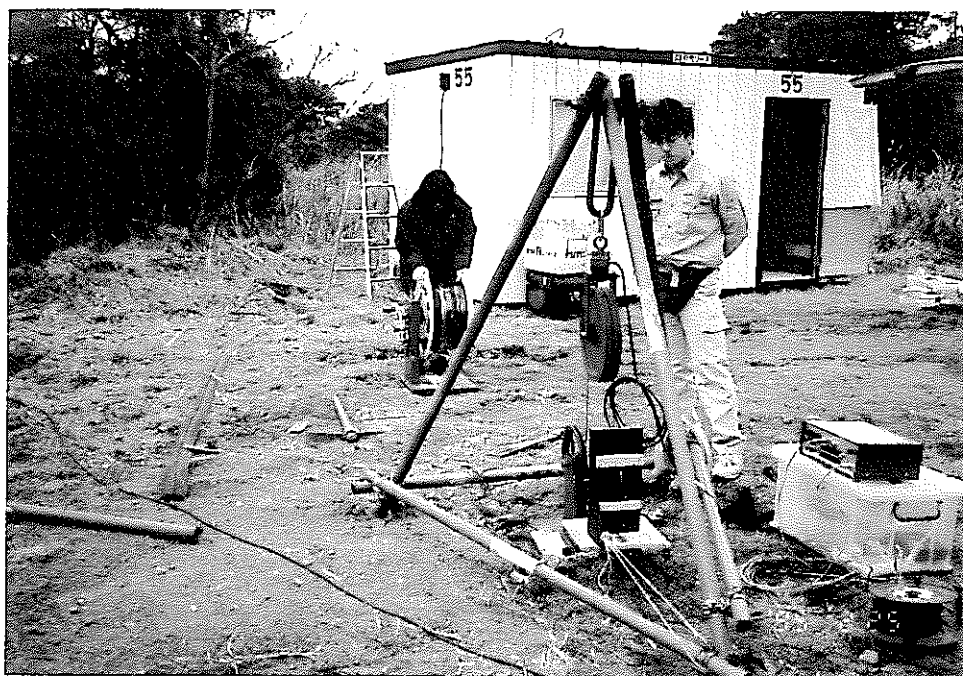
光ファイバケーブルの 挿入作業
