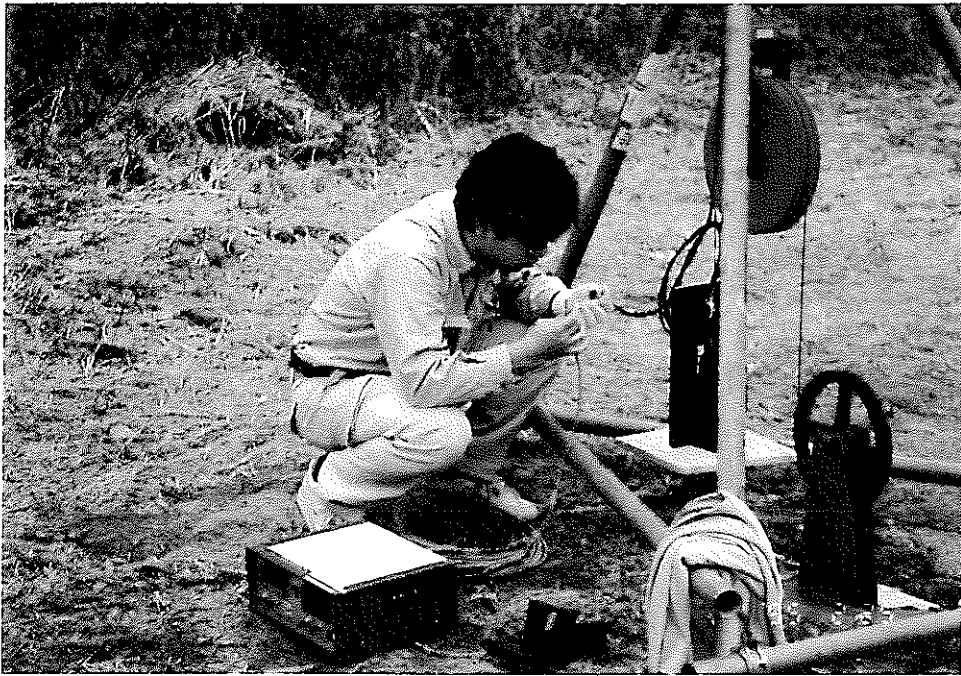
深度メータの接続作業
