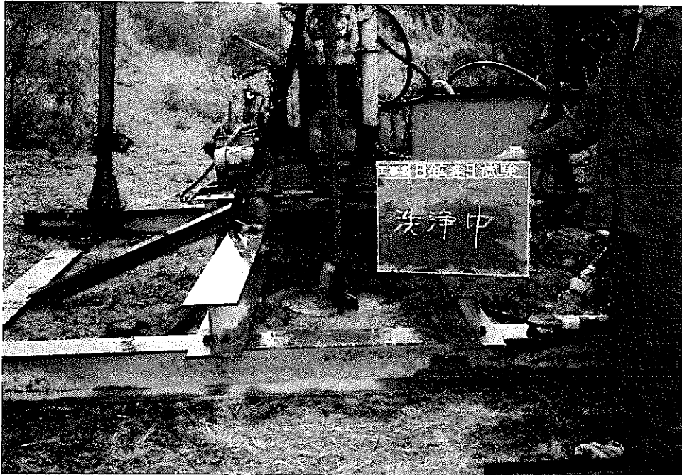
孔内洗浄作業
