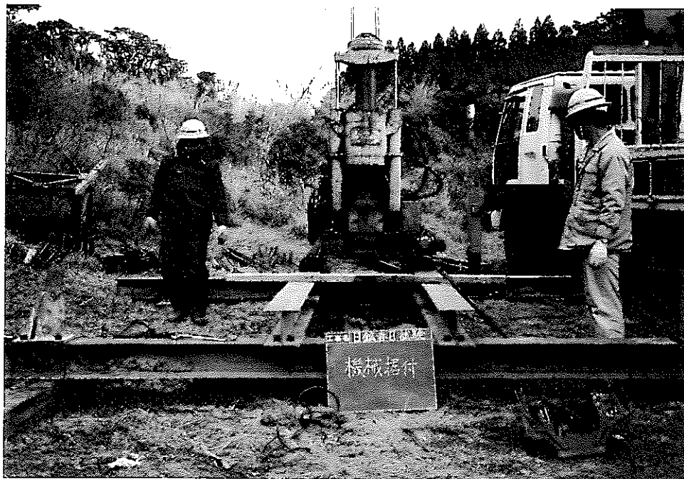
孔内洗浄機械の据付作業
