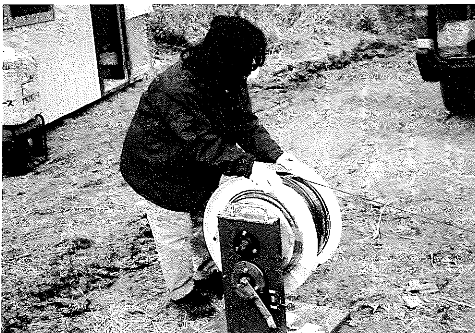
光ファイバケーブル 及び巻き上げドラム
