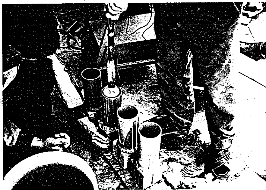
写真一Ⅷ・7 超音波発振での注入材打設状況
