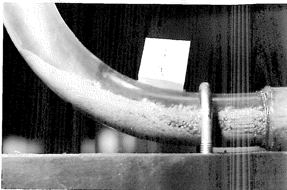
図3-26(a) 配管部1のスラッジ堆積状態
