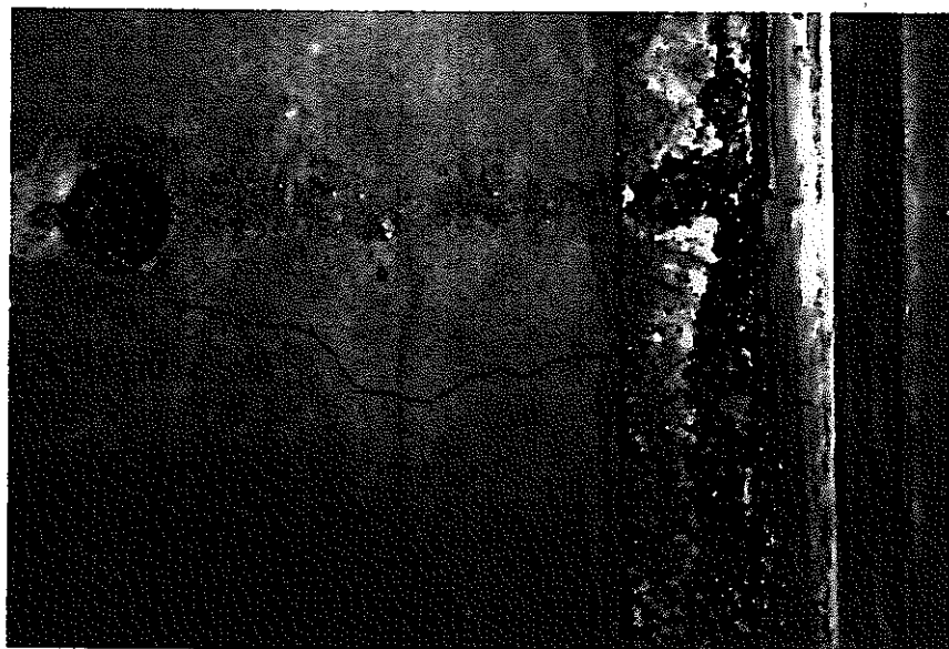
Photo. 2.4.4-3 試験後の耐熱コンクリートの表面 (クラック部)
