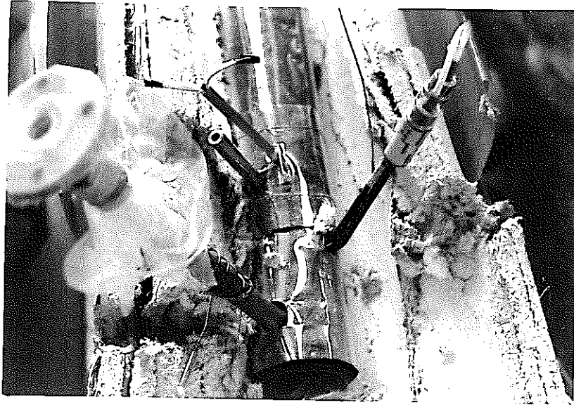
写真27 試験番号2 配管上流部
