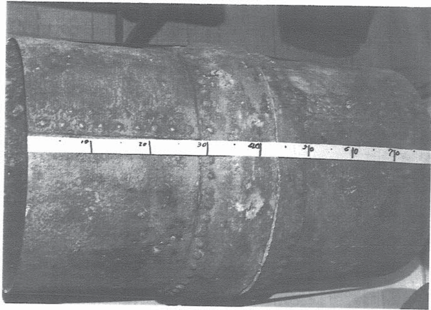
水道管外観状況
