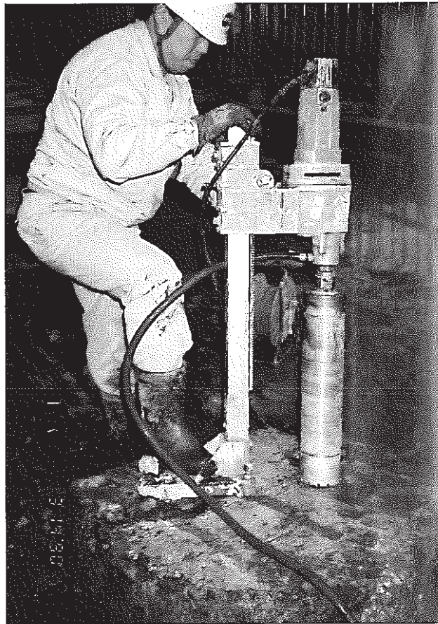
写真-9 前面部コアサンプリング状況 Photo.-9 Sampling of Core (Riverside)
