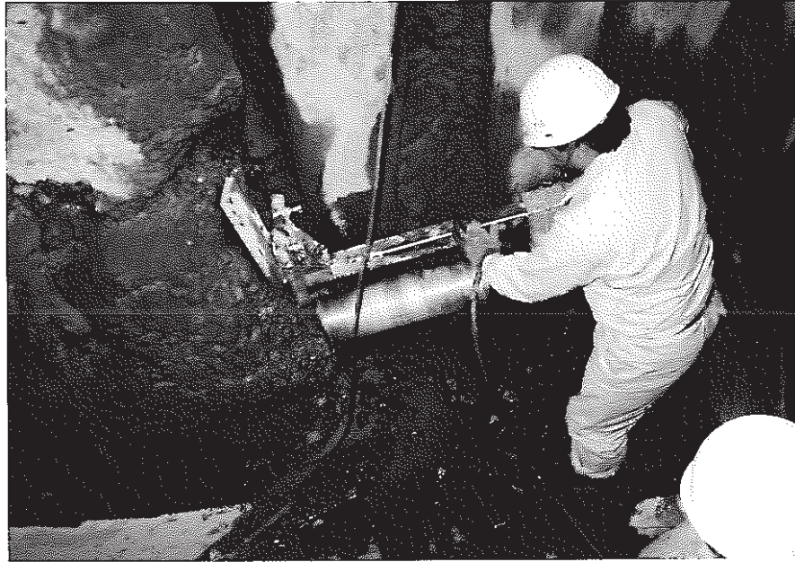
写真-6 背面上部コアサンプリング状況 Photo.-6 Sampling of Core (Upperpart of Landside)
