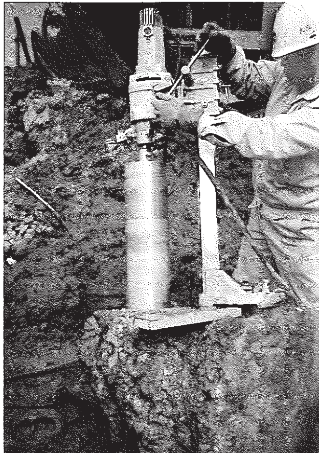
写真-7 背面下部コアサンプリング状況 Photo.-7 Sampling of Core (Lowerpart of Landside)
