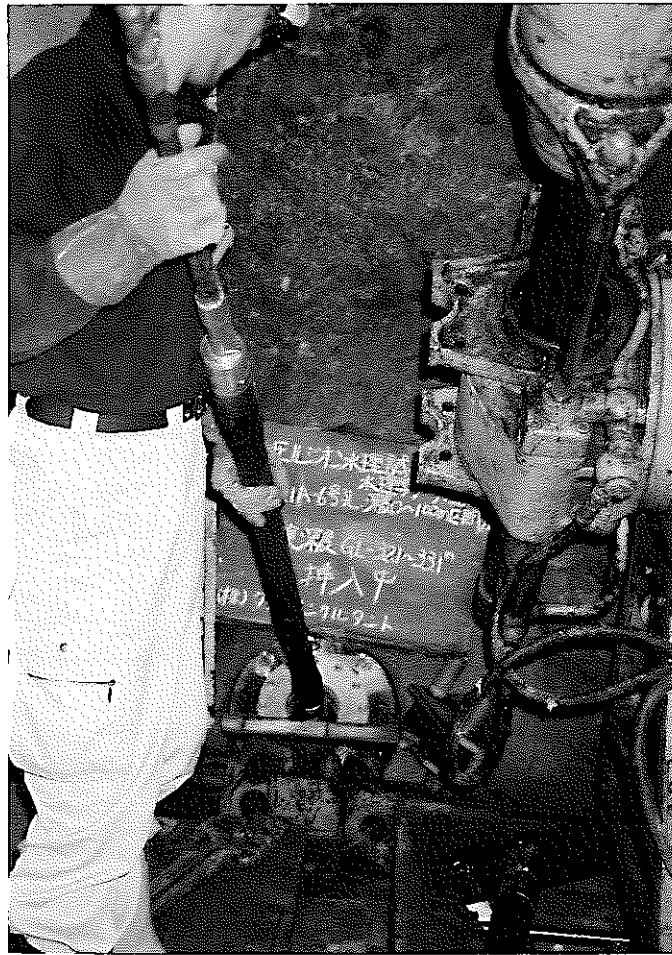
パッカー挿入中
