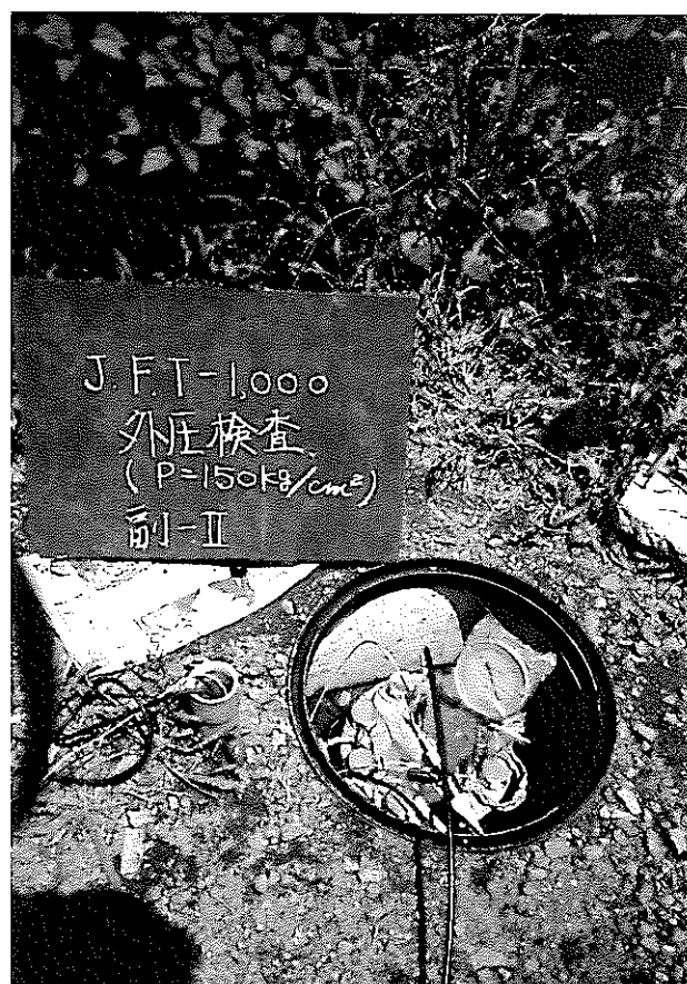
写真-6 検査圧力
