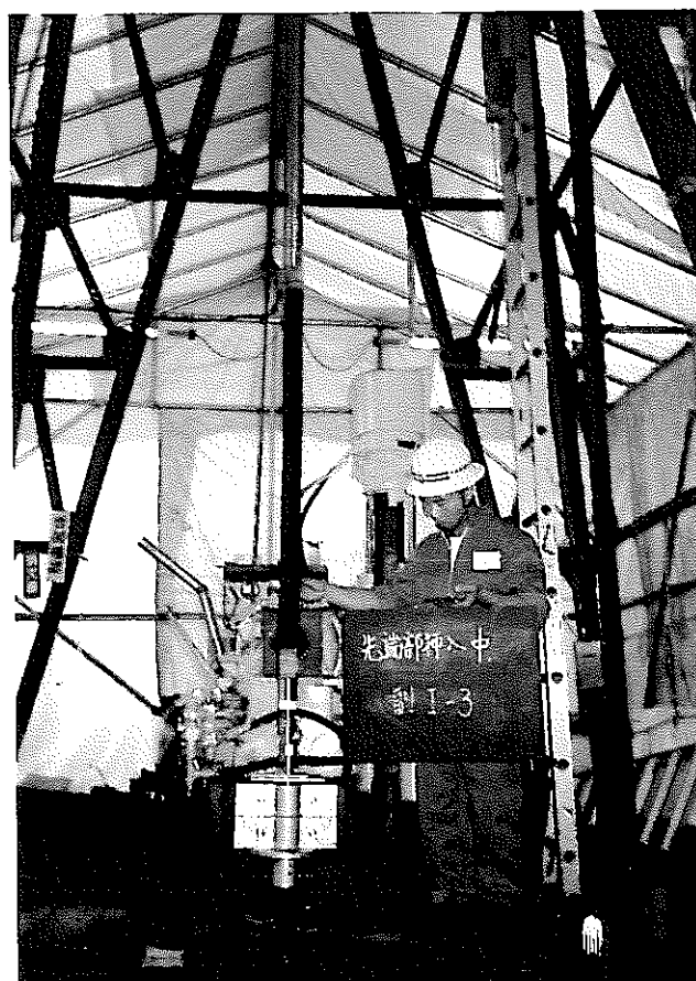
写真－４１ 副制御部Ⅰ－３挿入状況
