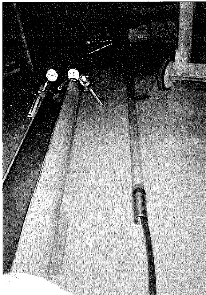
写真－２４ インナーパッカーキャリブレーション状況
