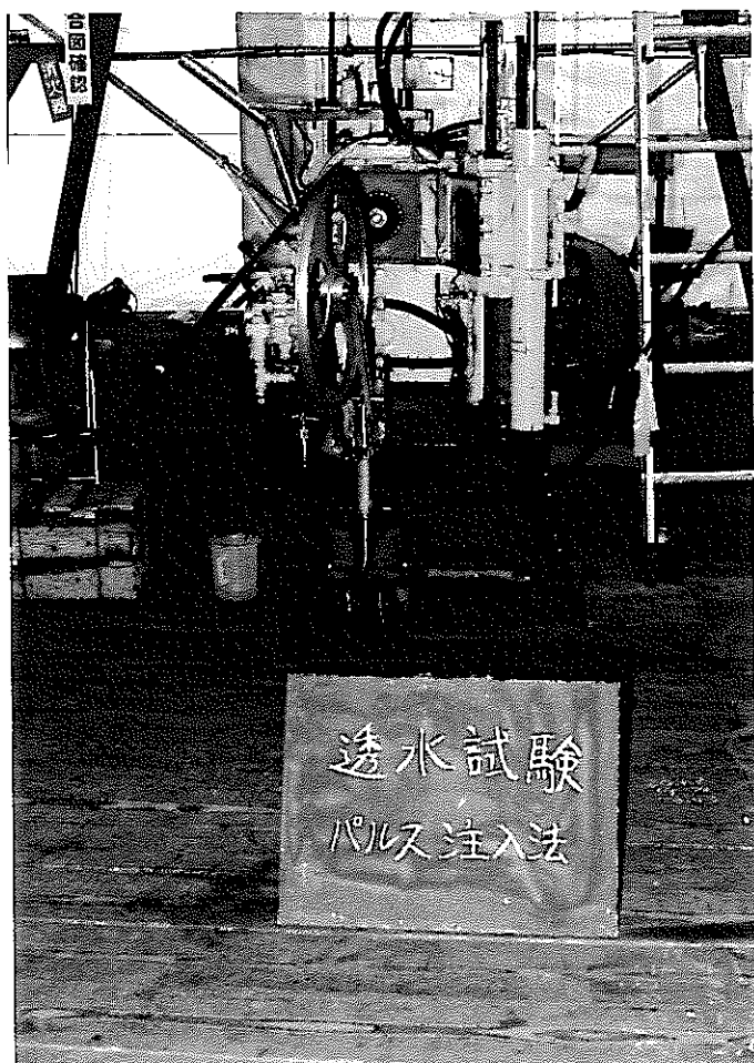
写真-5 1 透水試験状況
