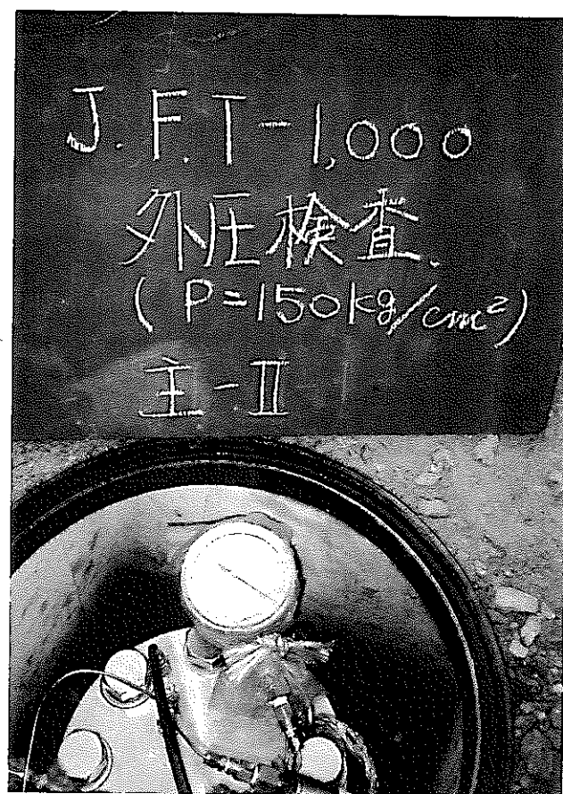
写真-3 検査圧力
