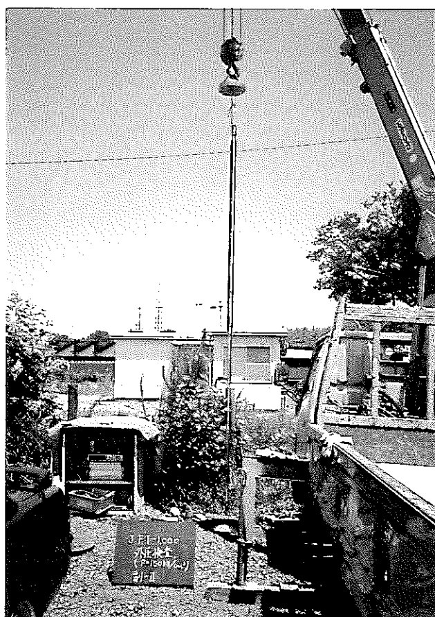
写真-5 副制御部Ⅱの耐圧試験
