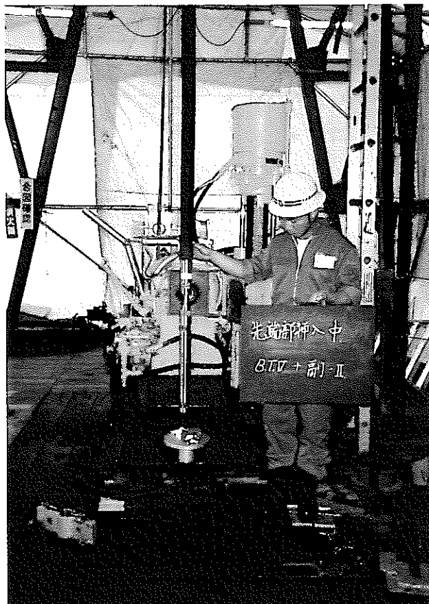
写真－４０ BTV + 副制御部Ⅱの挿入状況
