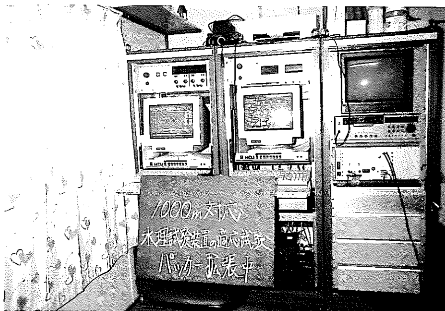
写真6 パッカー拡張状況
