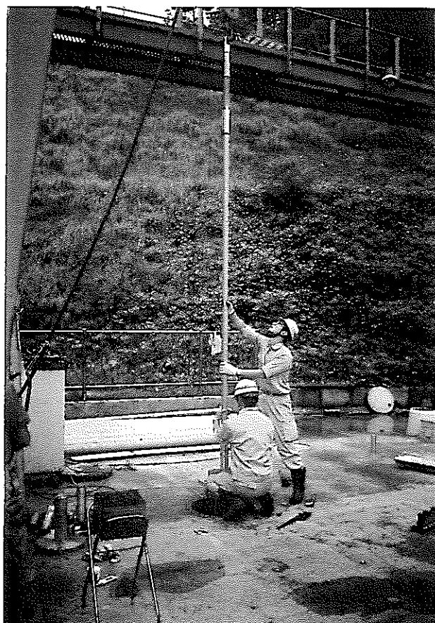
ダウンホールユニット（ケーシングパイプ）挿入孔口作業風景
