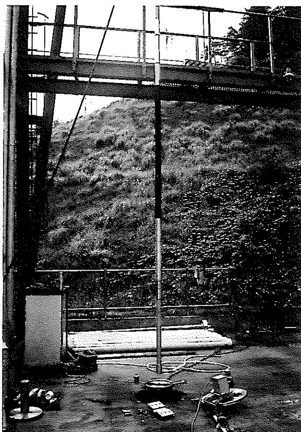
ダウンホールユニット（外部遮水パッカー）挿入孔口作業風景
