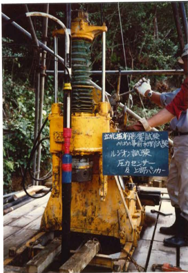
圧力センサー及び上部パッカー
