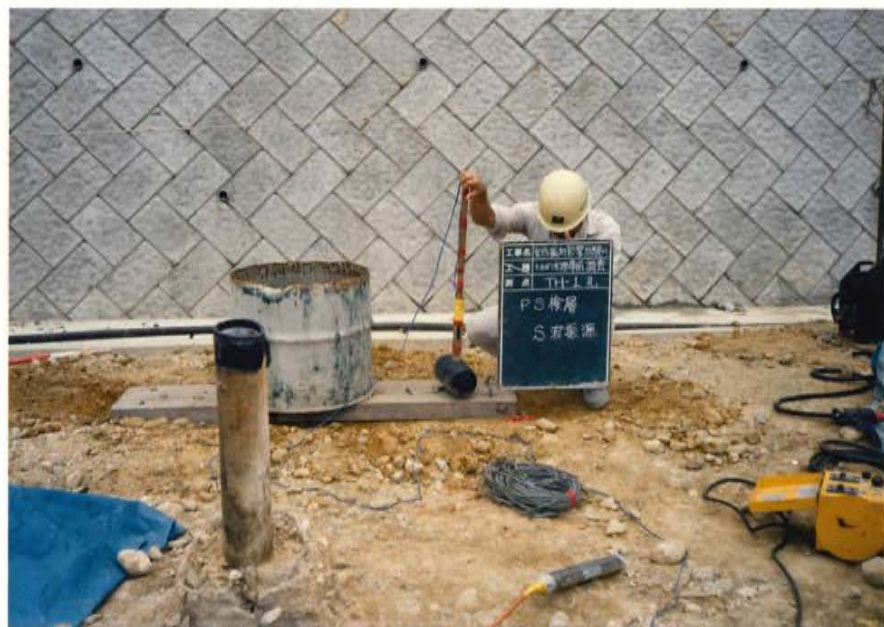
T H - 1 孔 S 波振源設置状況
