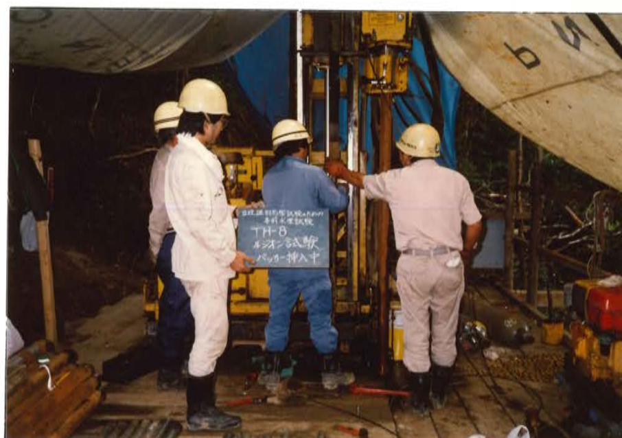
バッカー挿入中
