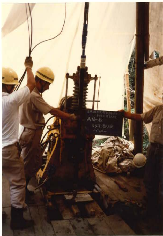
パッカー挿入中
