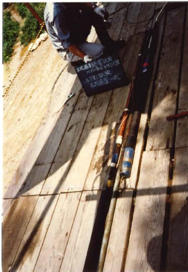
孔内装置1式（ダブルバッカー、ストレーナパイプ、圧力センサー、注水ホース） 孔内装置全景
