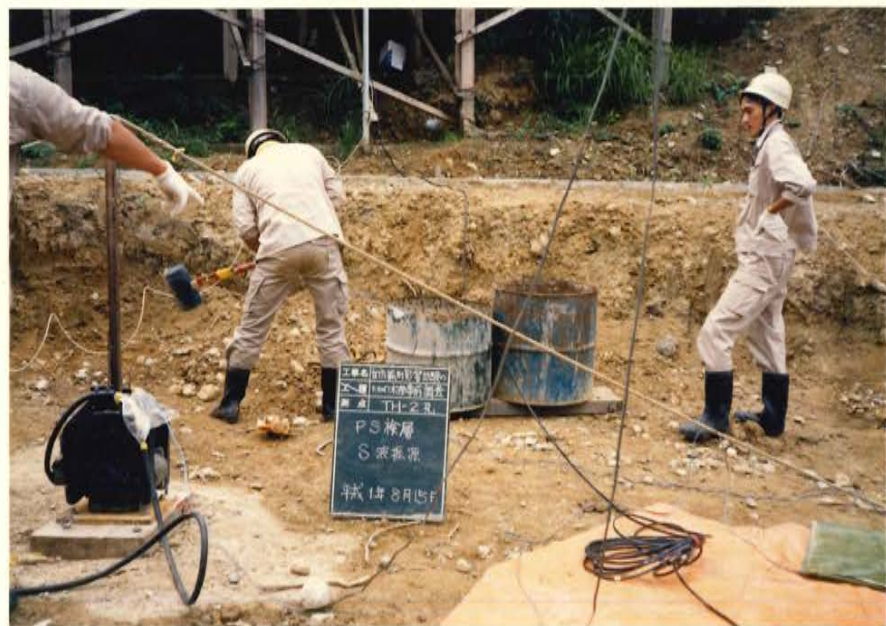
TH - 2 孔 S 波測定作業
