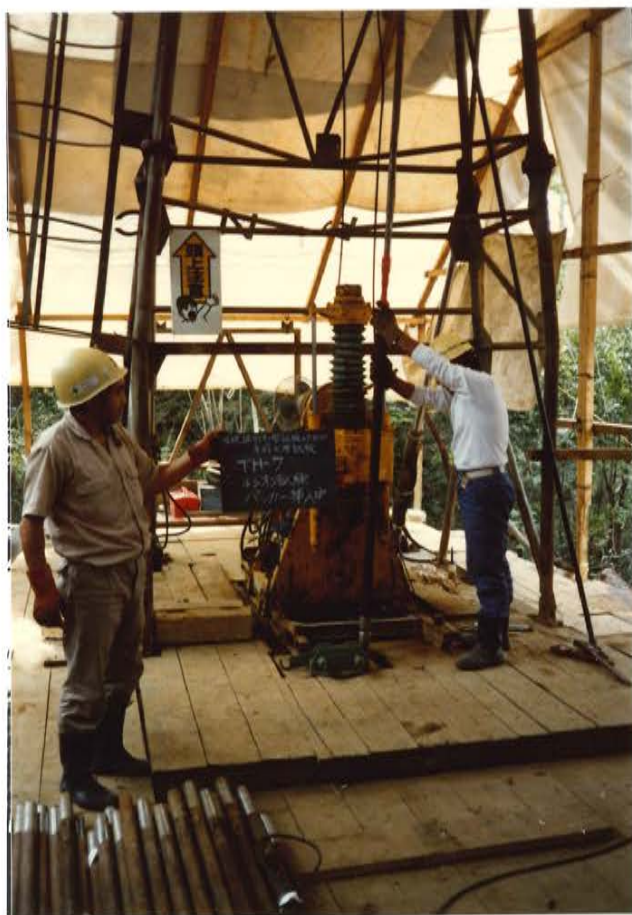
バッカー挿入中
