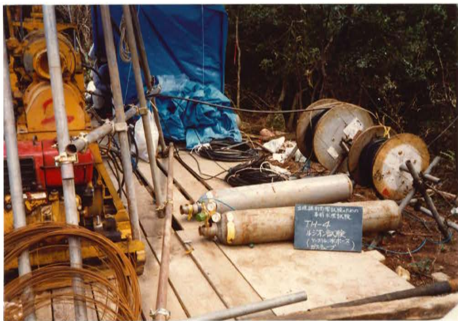
送水ホース、エアホース 窒素ガスボンベ
