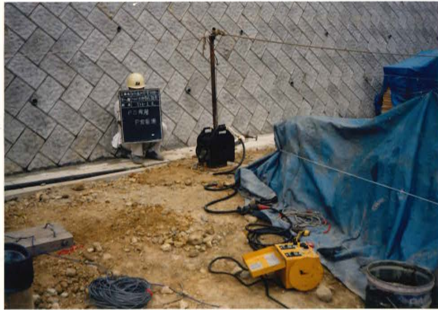
T H - 1 孔 P 波振源設置状況
