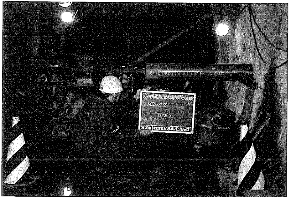
写真5 削孔状況 (MS-2孔)
