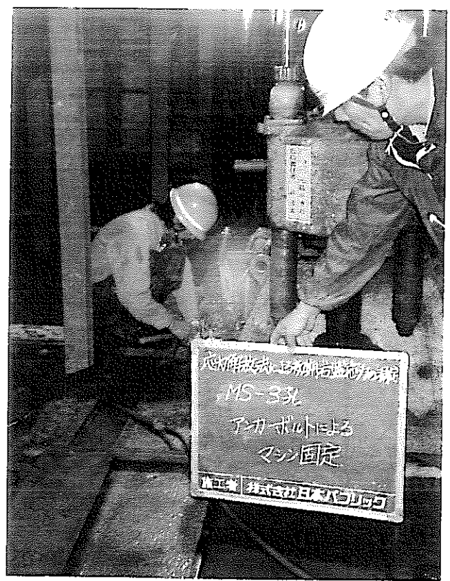
写真 1 ボーリングマシン設置状況 (アンカーで固定)
