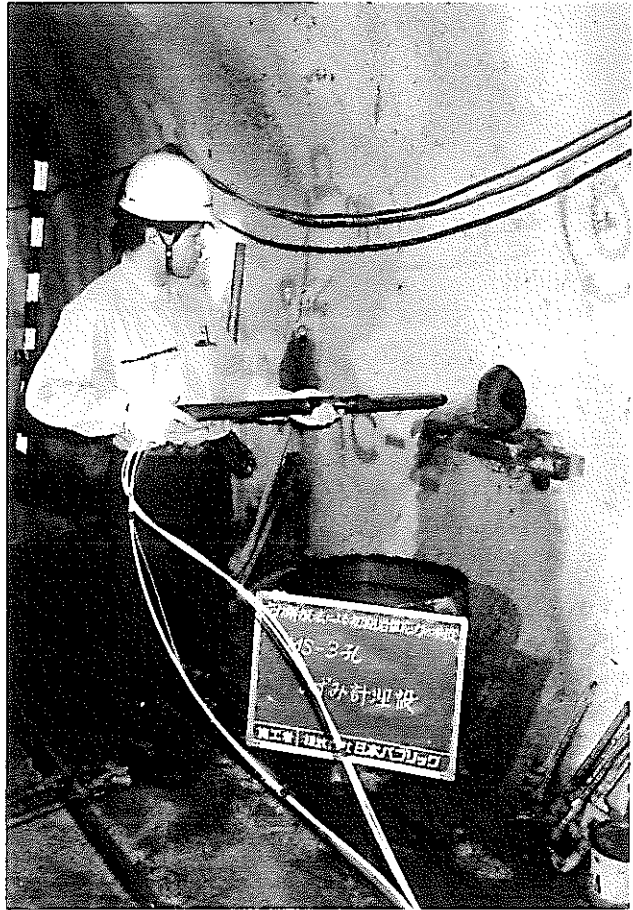
写真 13 8 成分ひずみ計埋設状況 (挿入状況)
