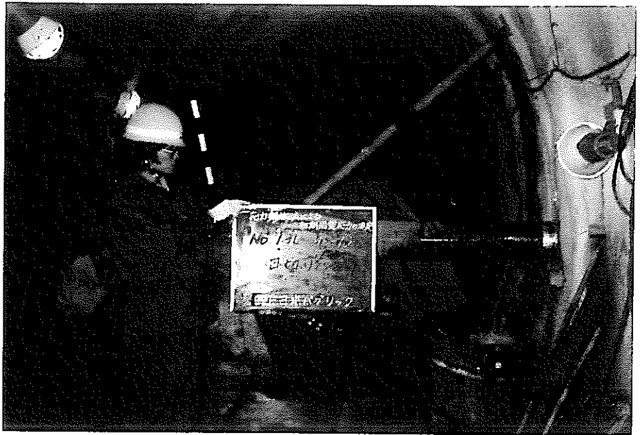
写真4 削孔状況 (MS-1孔)
