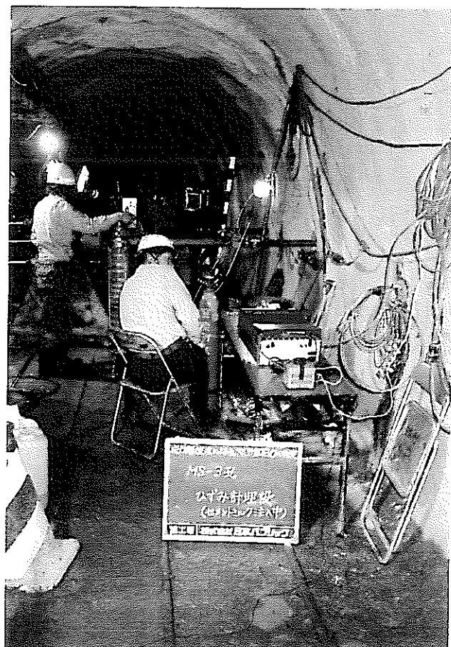
写真 17 充填材注入監視状況 (MS-3孔)
