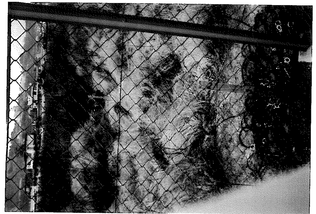
No. 12 : Line96-A No. 21 の 荒れ地内付近
