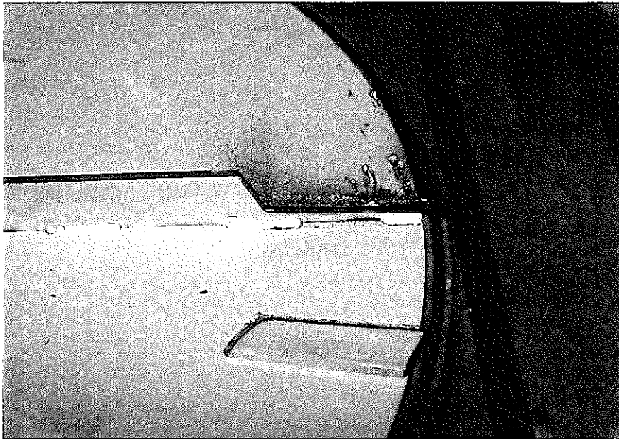
(b) 補強板の切断状況
