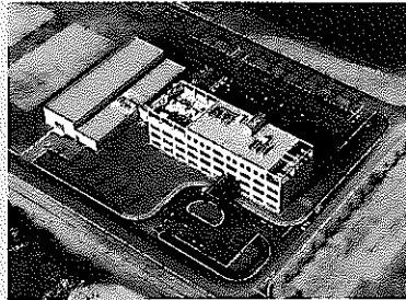
地層処分基盤研究施設
