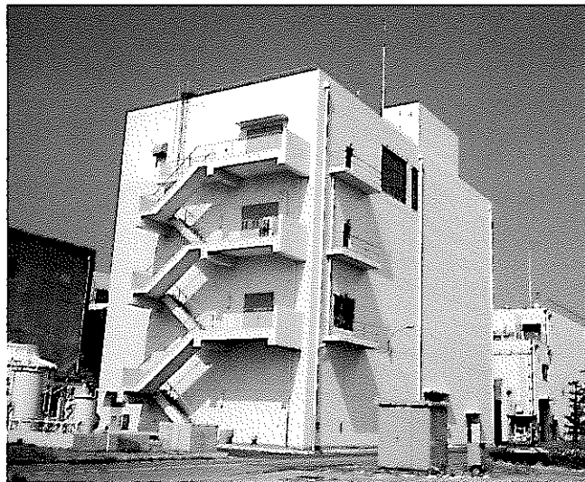
◀東海事業所再処理施設内新焼却施設完成(3.7)
