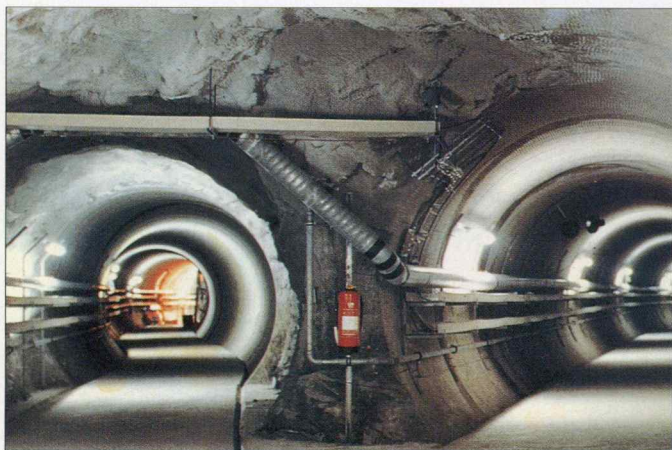
上：トンネル内部 右：試験現場
