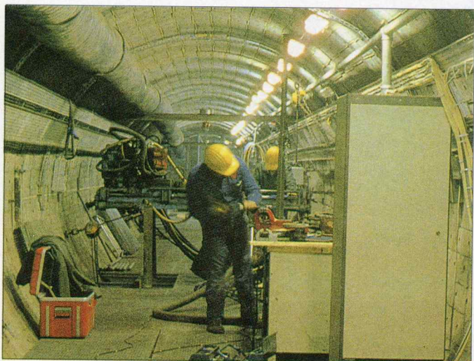
トンネル内部
