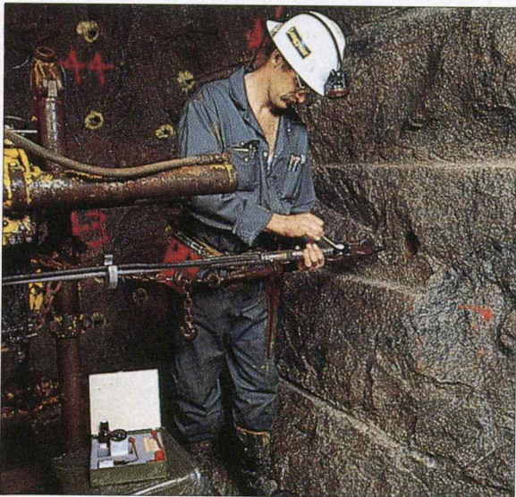
右.. 応力測定試験状況 左.. トンネル内部
