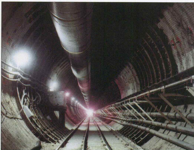
トンネル内部
