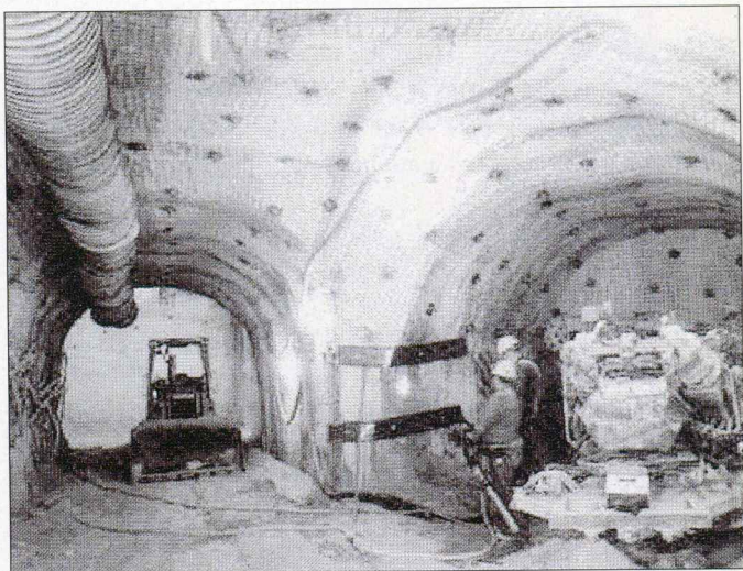
建設中のアルコーブ
