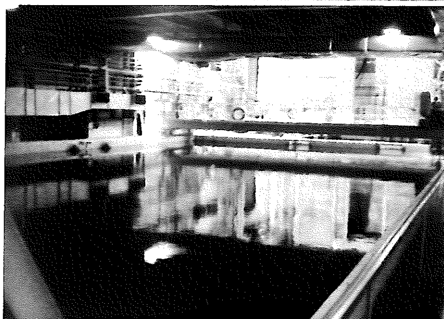
燃料貯蔵プール
