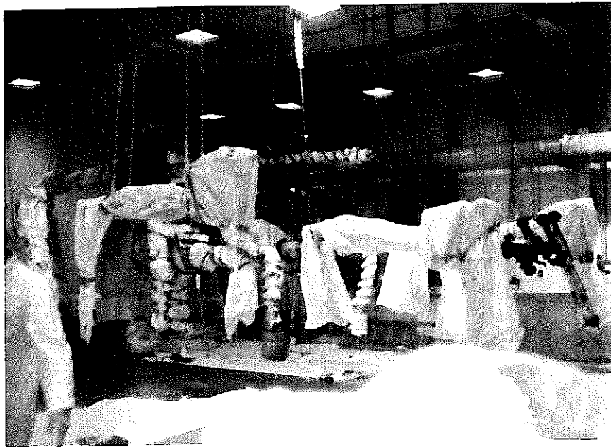
マニピュレータ修理室
