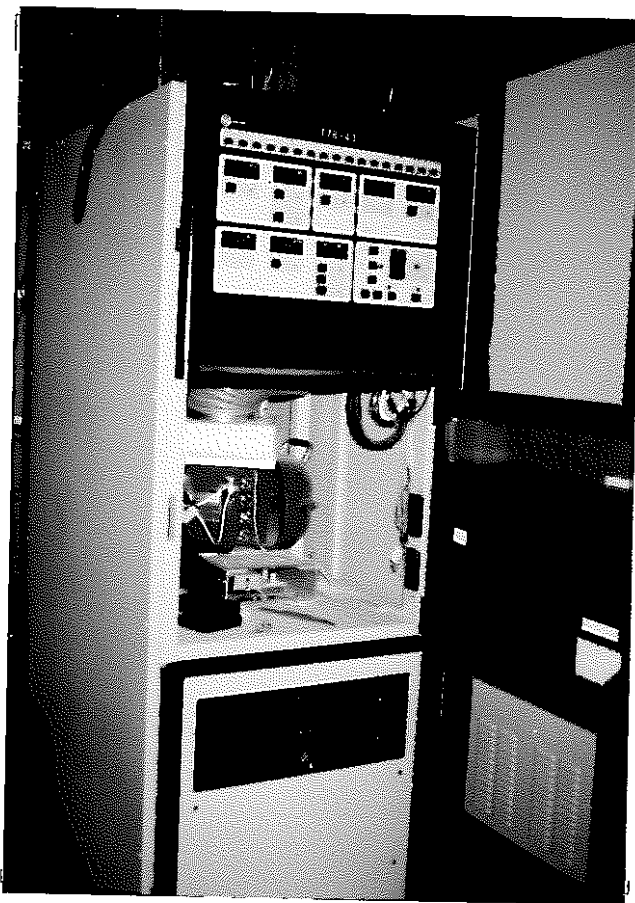
③⑨ CEBAF RF系 (ステト用) クライストロン (赤) 及びクライストロン電源 5KW CWのパワーを取り出せる。
