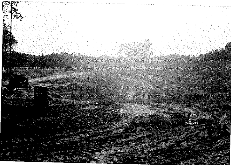
⑥ CEBAF 旧NASAの研究所の跡。CW 超電導加速器を建設するカンバン がかかっている所は実験室、工事 中の所はライナックトンネルの部 分。
