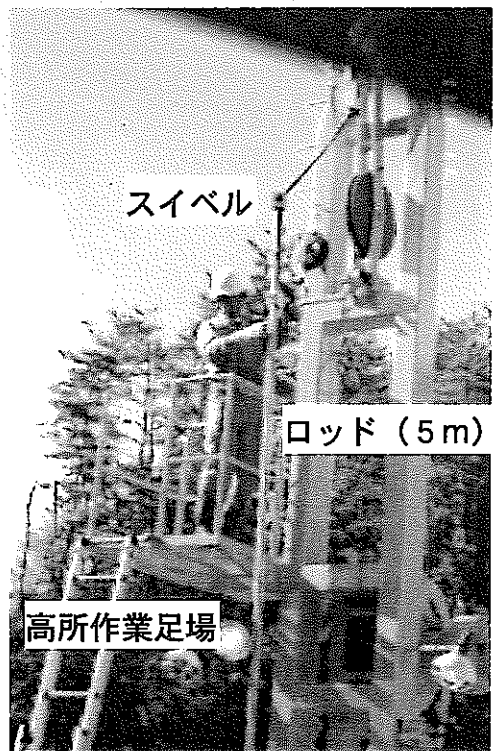
写真-4 ロッド吊り上げ (芯出し)
