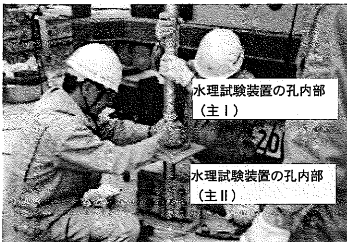
写真-3 孔内部連結
