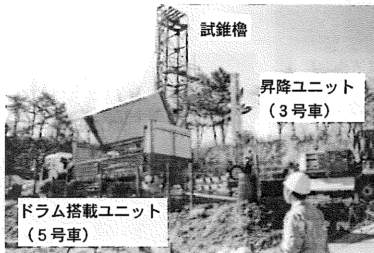
写真-1 3 櫓設置時の配置
