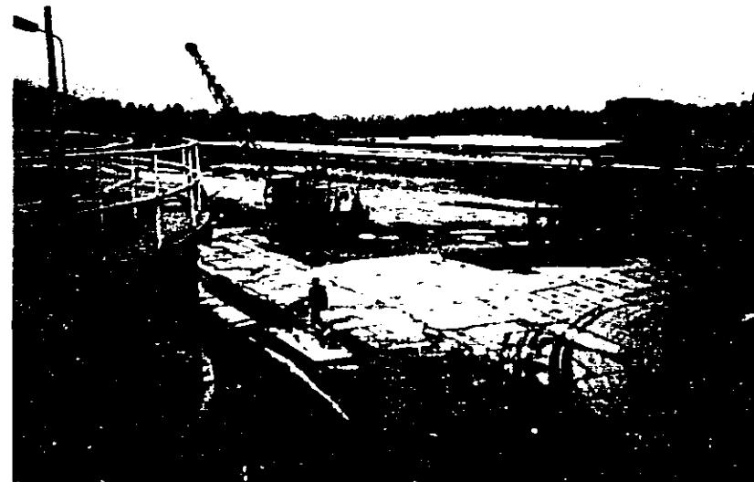
写真-2 Königstein鉱山坑廃水処理施設、シックナーと沈澱池
