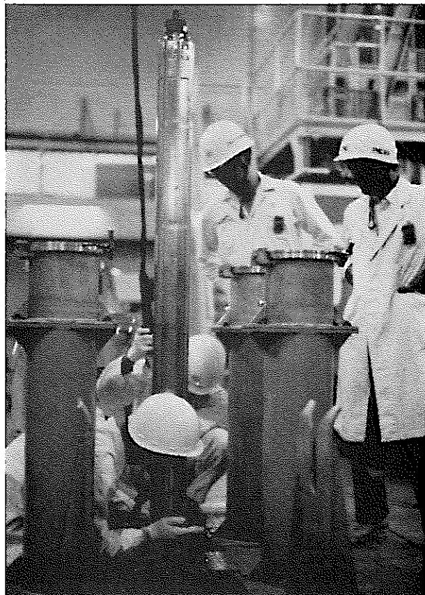
写真 8.2.2 シュラウド・チューブ挿入試験(1)
