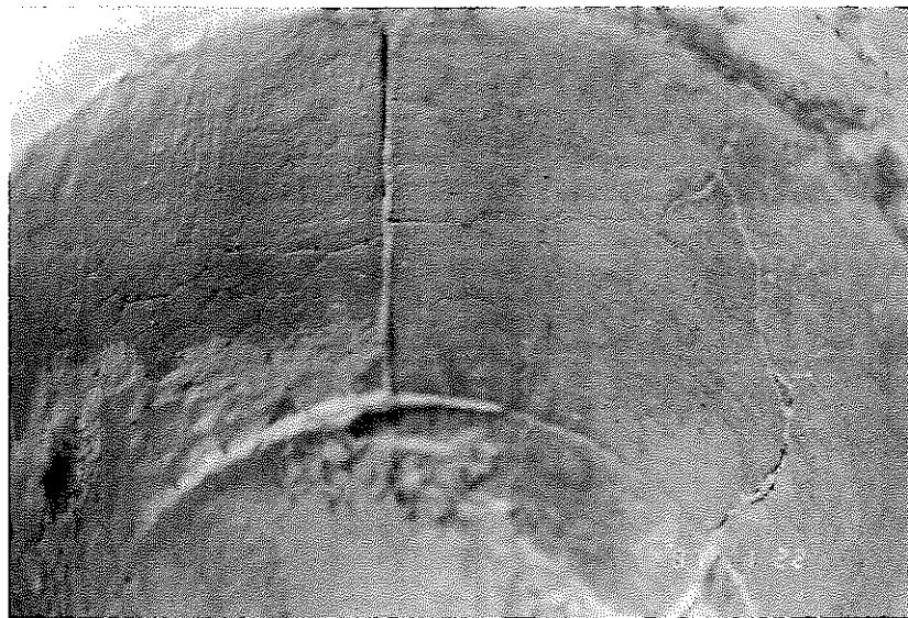
図-8. コニカル部電融アルミナのひび割れ
