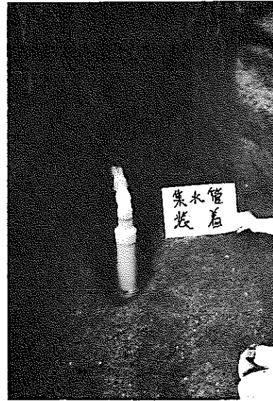
写真V-2 浸透水集水器の設置状況
