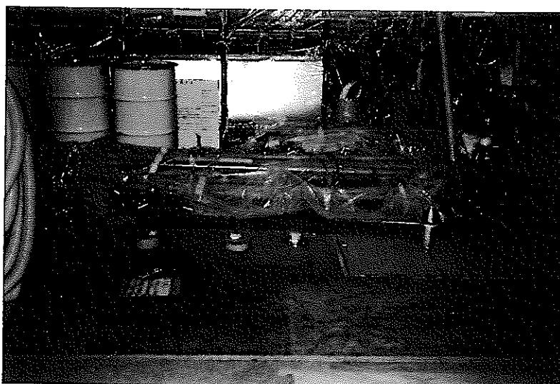
写真 3.3-15 屋内廃水ピット用サンプリング配管の外観
