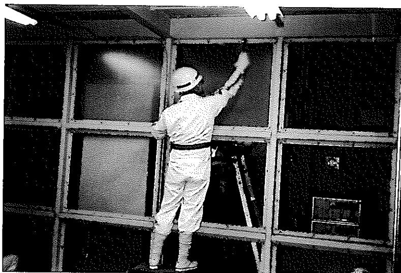
写真 3.3-5 フードパネルの撤去状況
