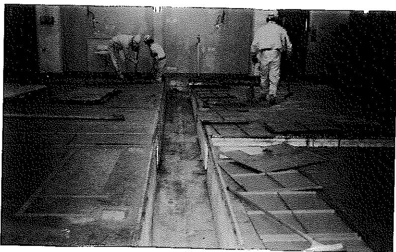
写真 3.3-20 トレンチ内の撤去状況
