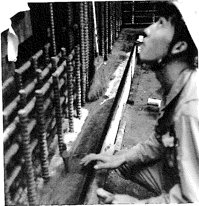
G51M130, 131 貫通スリーブ 出入り調整作業 (墨線確認)
