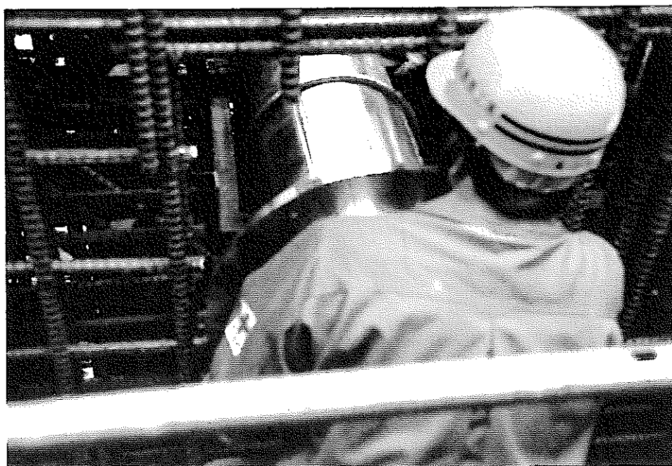
G51M130, 131 貫通スリーブ レベル出し作業
