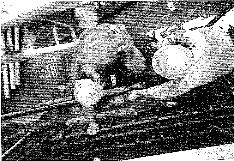
G51M132, 133 貫通スリーブ 出入り調整作業 (墨線確認)
