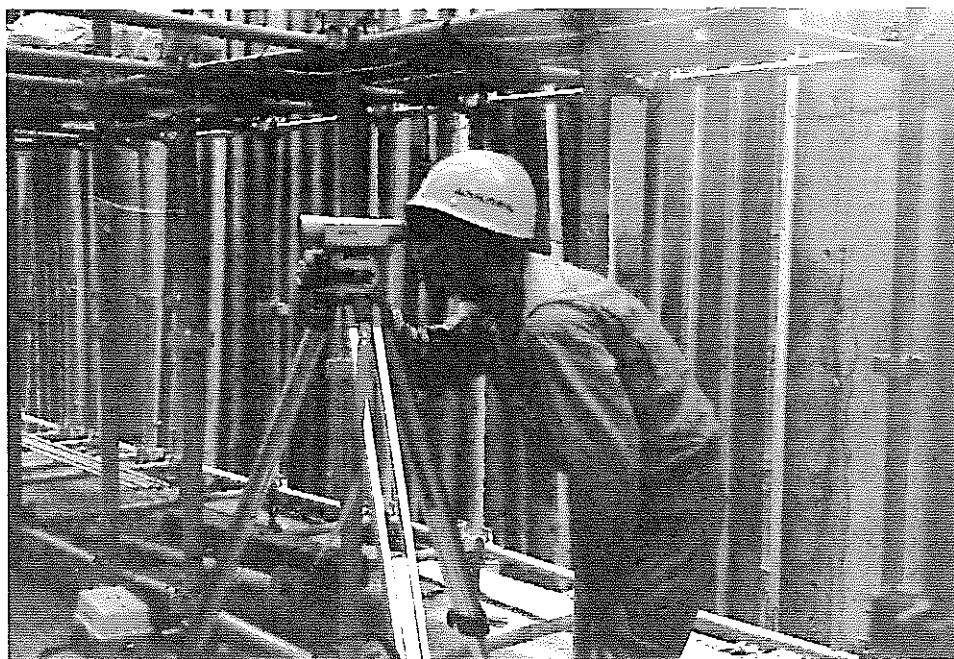
G51M132, 133 貫通スリーブ Yレベル確認作業
