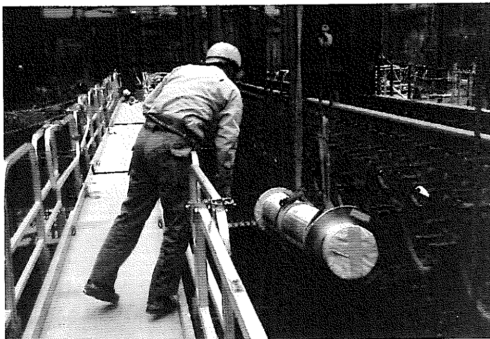
G51M132, 133 貫通スリーブ 吊り下ろし作業
