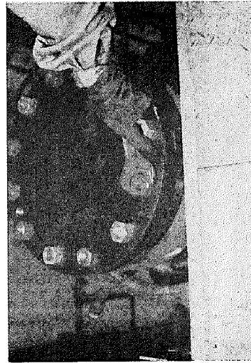
写真14 破壊板の盲蓋との取りかえ作業
