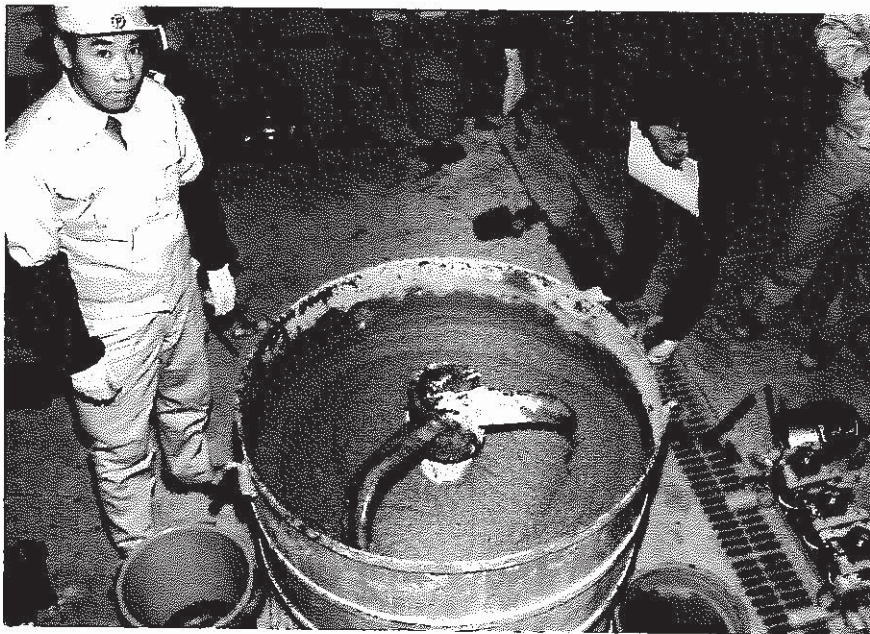
写真-4 パーライトコンクリートの練り混ぜ
