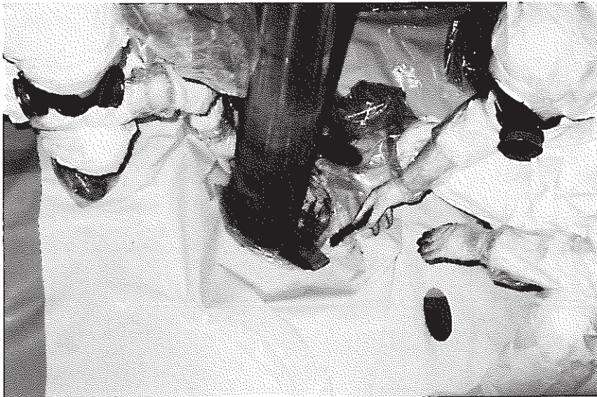
写真 4.1.2 - 3 孔プラグ付着ナト リウム除去作業
