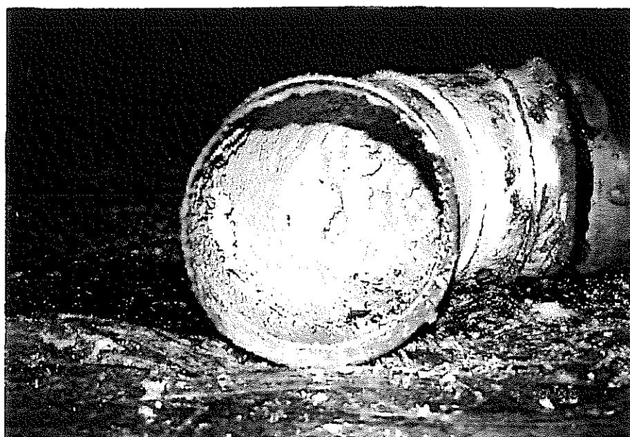
写真3 換気空調ダクト（Φ200mm） 曲がり部内面
