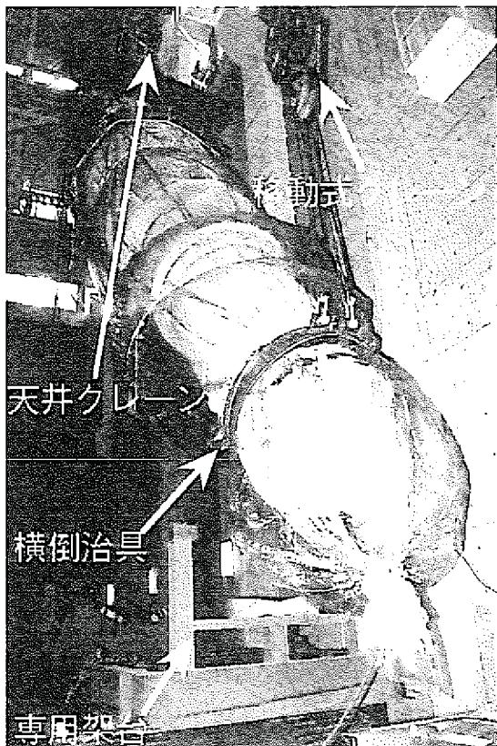
写真4.1.3-4 管束の吊り下ろし・横倒し
