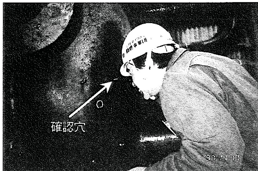
写真4.2.3-4 上部鏡板内のN a付着状況確認
