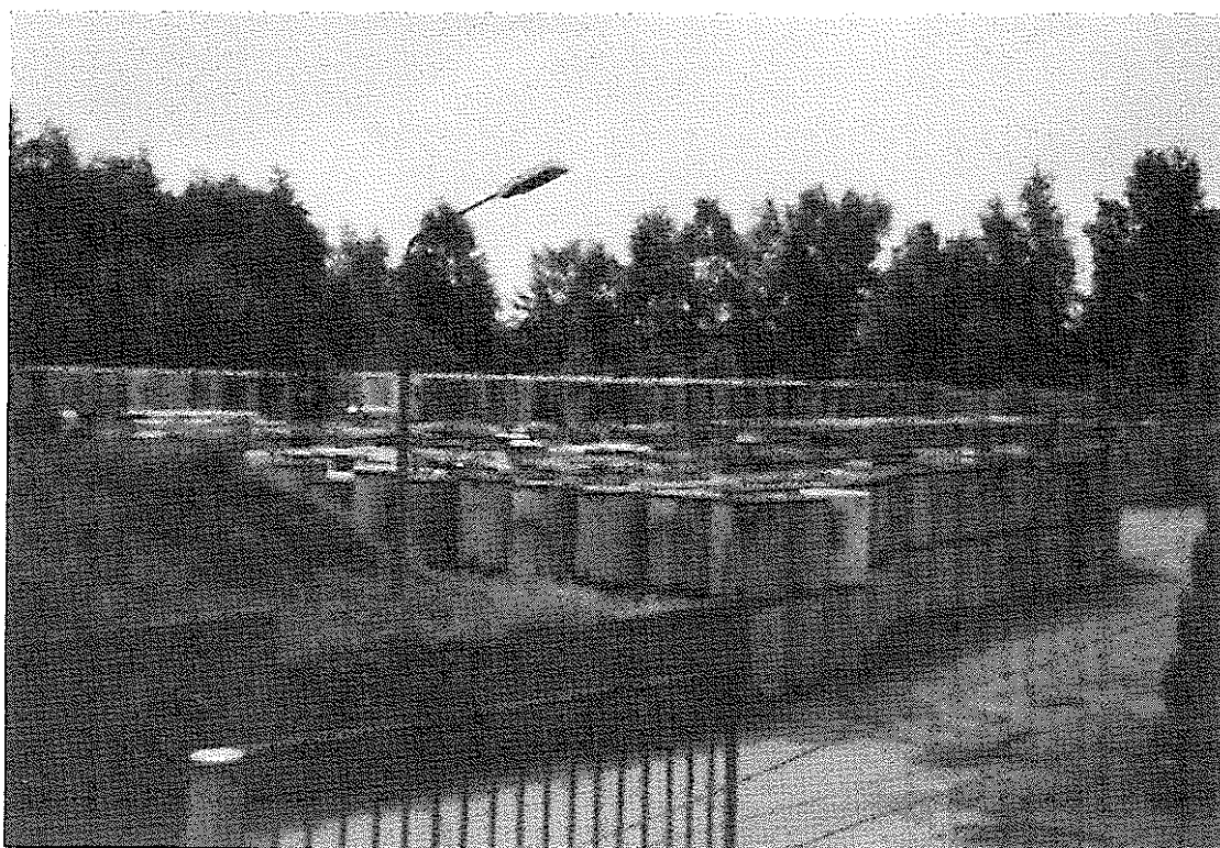
写真7 高レベル廃棄物貯蔵庫
