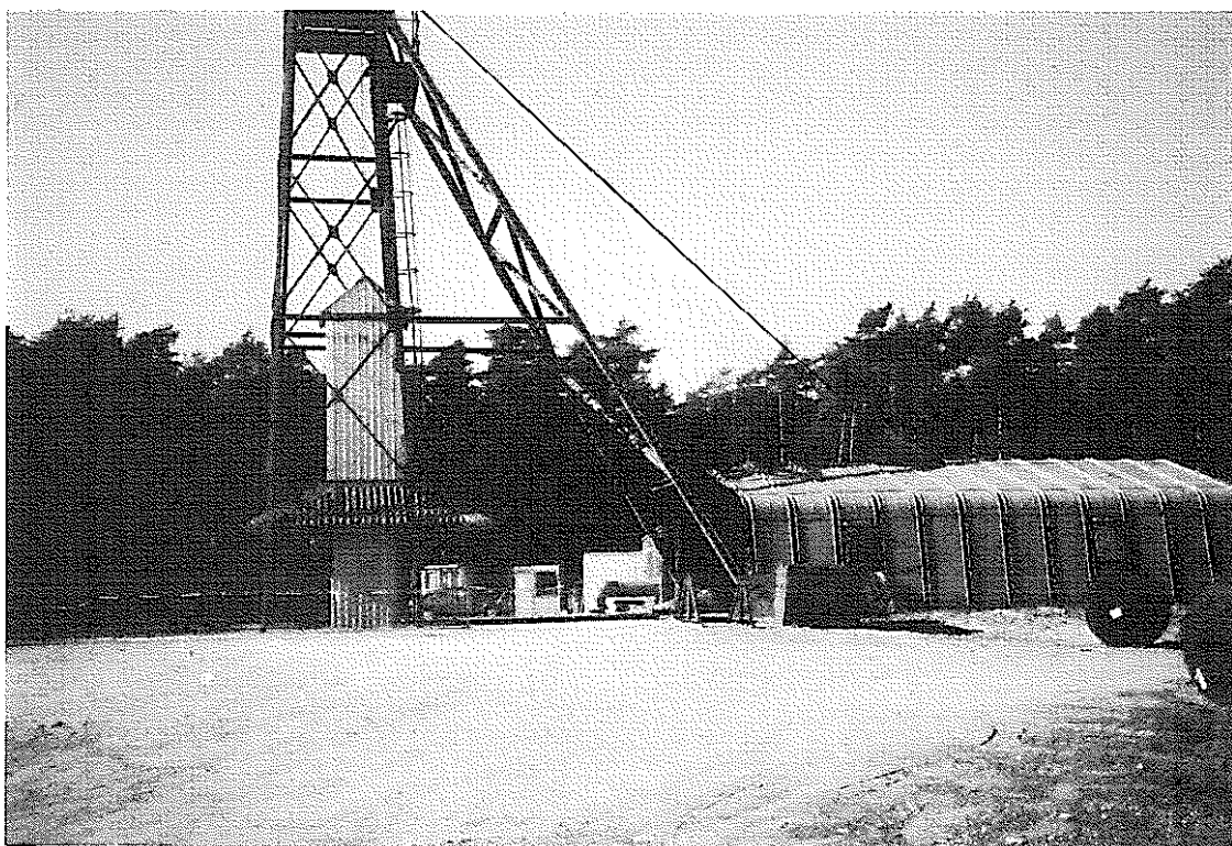
写真8 処分のための地下実験室（リフト）
