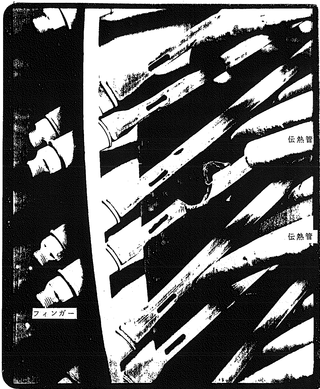
SH3 Uベンドフィンガー部のフレッティング状況
