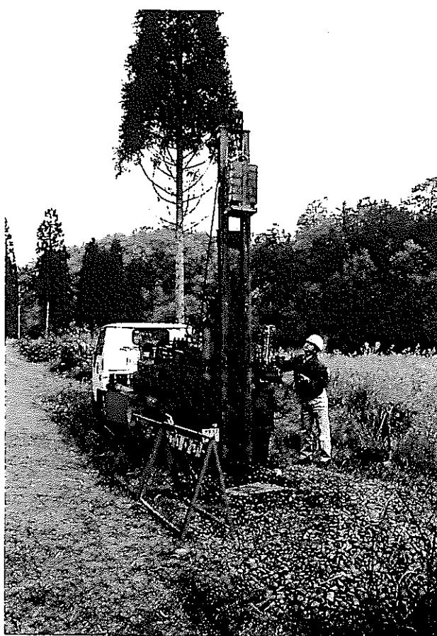
図-4-2-4 重錘落下による発震作業
