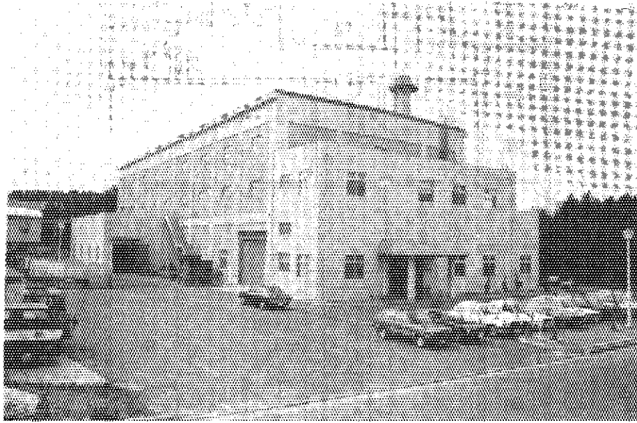
図 3.1 第 2 廃棄物処理棟外観
